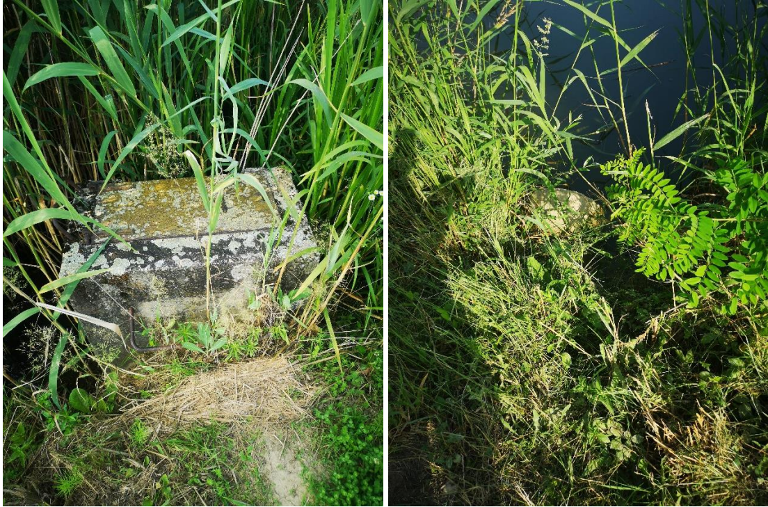
Slika 5.2.13. Propust i cijev za punjenje jezera (21.06.2023.)[12]
