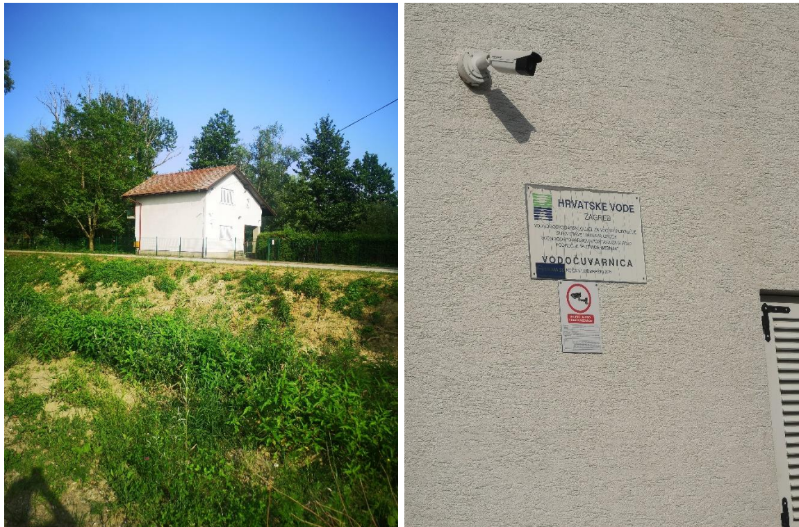
Slika 4.1. Vodočuvrnica kod brane u Kućanu Ludbreškom [12]
