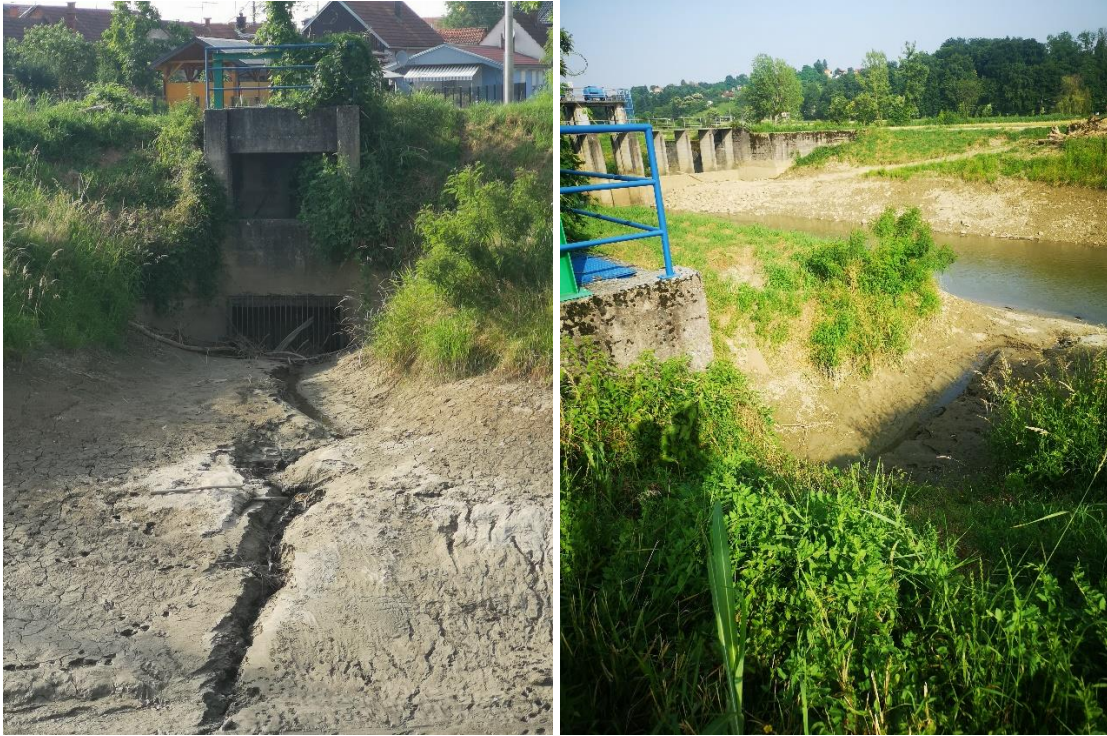
Slika 5.2.7. Propust na ulazu u derivacijski kanal (21.06.2023.)[12]
