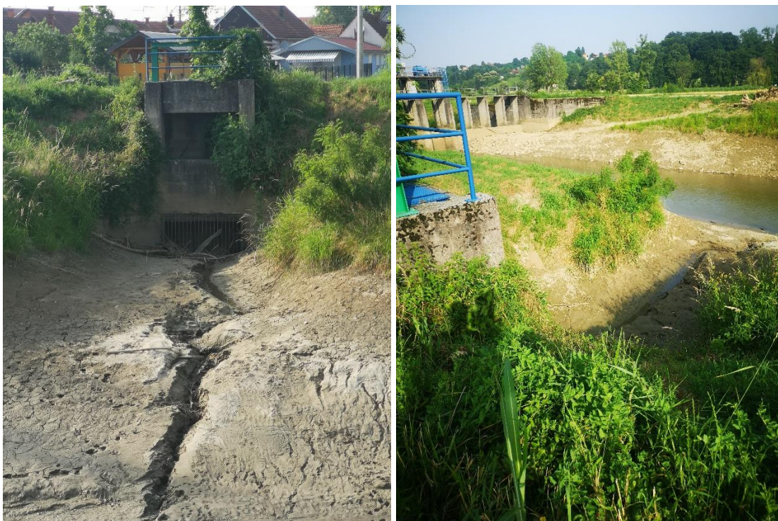
Slika 5.2.7. Propust na ulazu u derivacijski kanal (21.06.2023.)[12]
