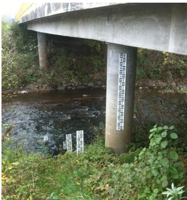
Slika 3.3.1. Vodomjerna stanica Ključ [6]
