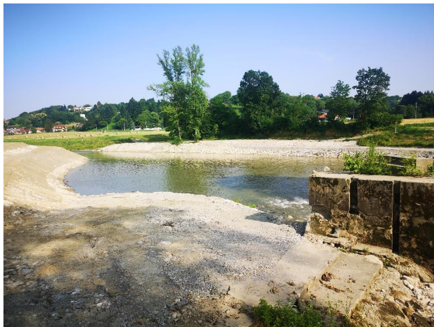
Slika 5.2.5. Obaloutvrda na rijeci Bednji [12]
