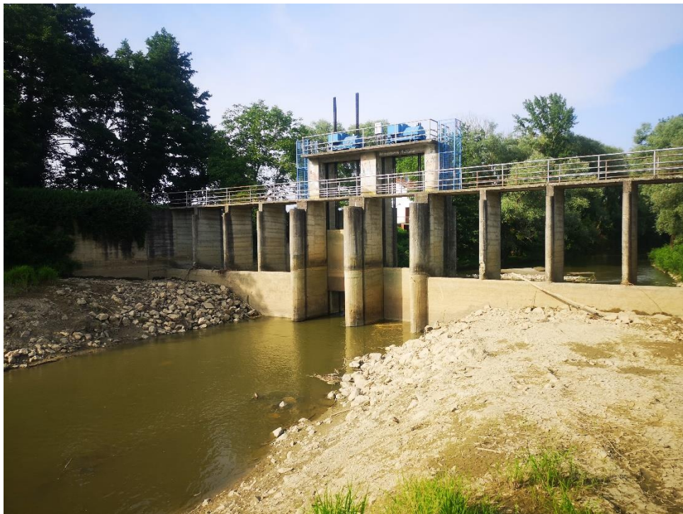
Slika 4.2. Brana u Kućanu Ludbreškom [12]
