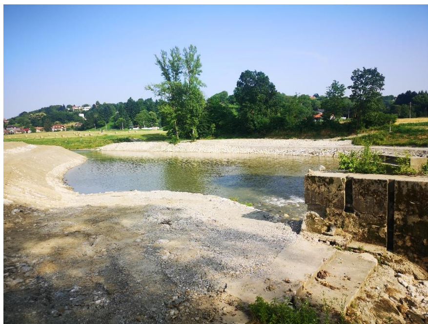
Slika 5.2.5. Obaloutvrda na rijeci Bednji [12]
