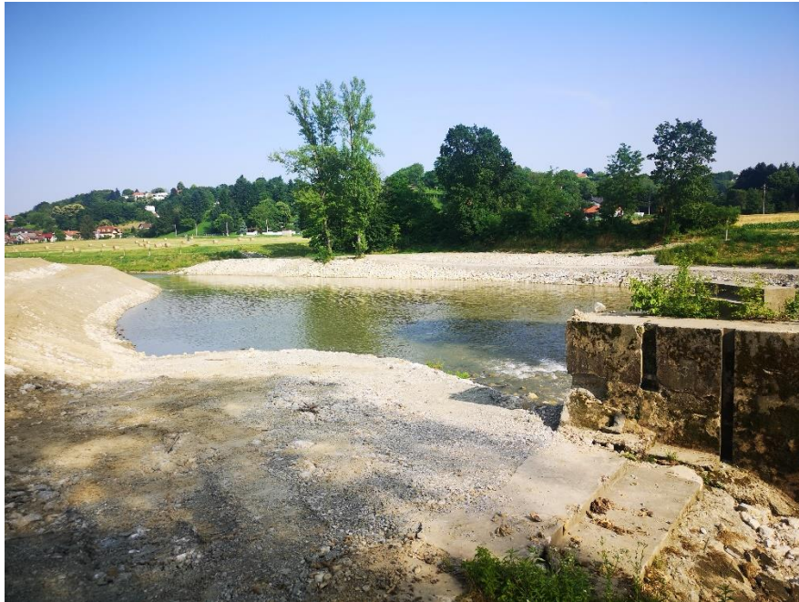
Slika 5.2.5. Obaloutvrda na rijeci Bednji [12]
