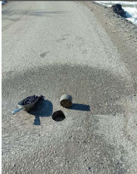
Slika 16. Obilazak županijske ceste ŽC 3257
