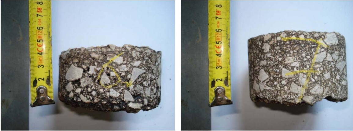
Slika 19. Ispitivanje debljine nosivog sloja (ŽC 3257)
