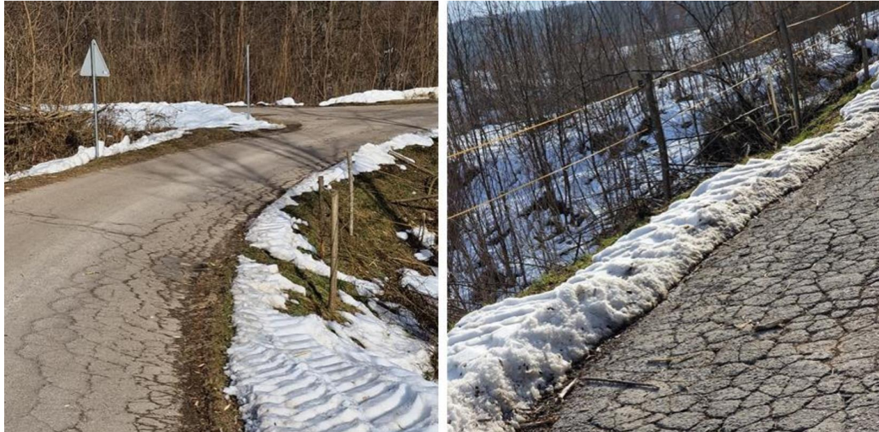
Slika 18. Puzanje bankine i procjeđivanje vode kroz bankinu
