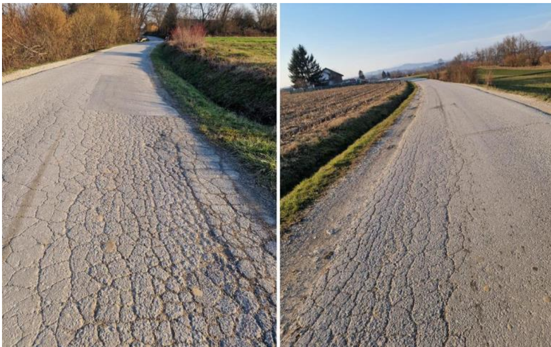
Slika 10. ŽC 3143; Stacionaže: km 4+420 ÷ km 2+420
