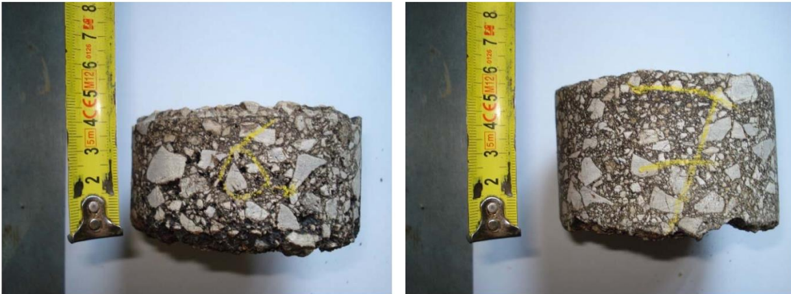
Slika 19. Ispitivanje debljine nosivog sloja (ŽC 3257)
