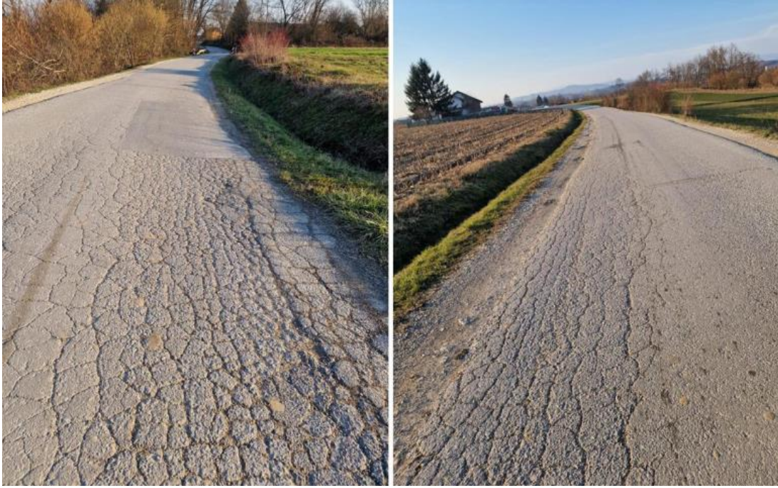
Slika 10. ŽC 3143; Stacionaže: km 4+420 ÷ km 2+420
