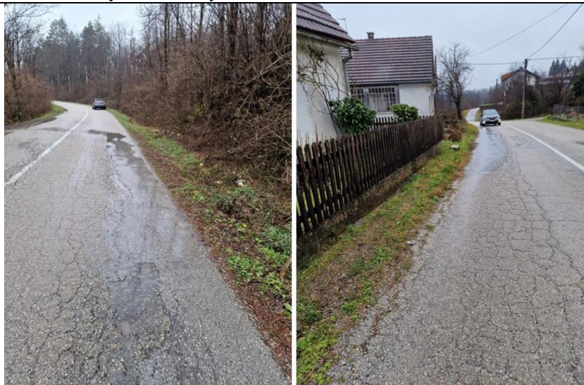
Slika 22. Županijska cesta ŽC 3176; Stacionaže: km 11+030 ÷ km 8+530
