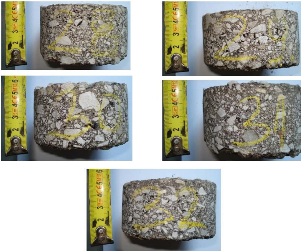
Slika 24. Ispitivanje debljine nosivog sloja (ŽC 3176)
