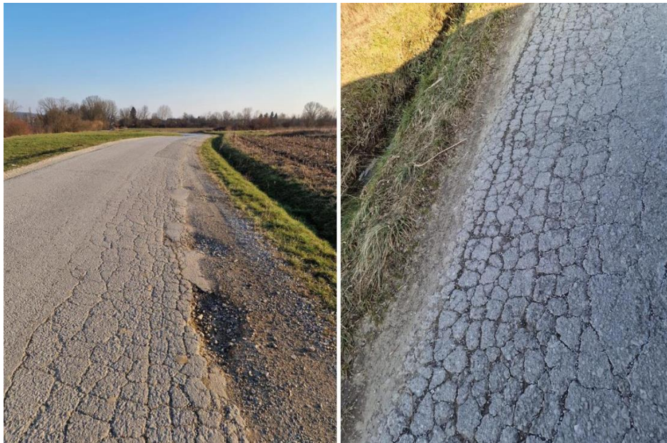
Slika 11. Puzanje bankine i procjeđivanje vode kroz bankinu
