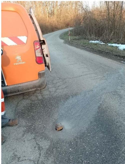
Slika 5. Obilazak lokalne ceste LC 34059
