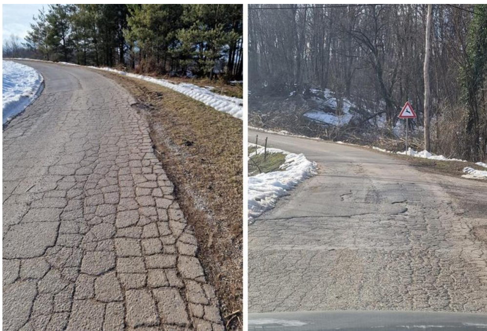
Slika 17. ŽC 3257; Stacionaže: km 0+000 ÷ km 1+100
