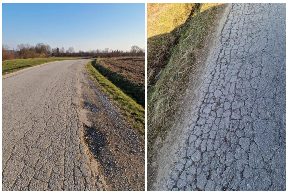
Slika 11. Puzanje bankine i procjeđivanje vode kroz bankinu
