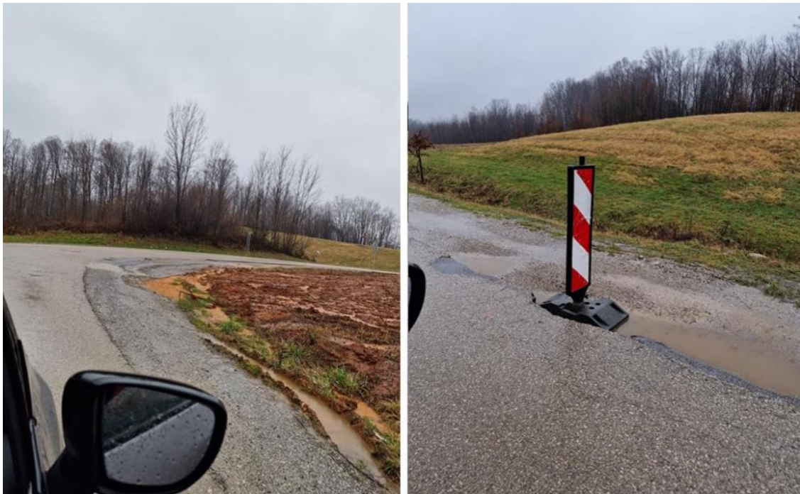
Slika 4. Lokalna cesta LC 34059; Stacionaže: km 0+230 ÷ km 1+610
