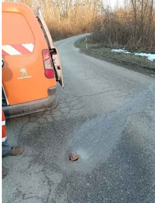
Slika 5. Obilazak lokalne ceste LC 34059
