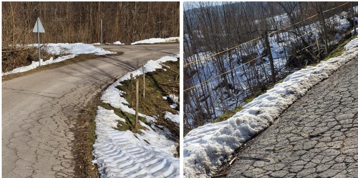
Slika 18. Puzanje bankine i procjeđivanje vode kroz bankinu
