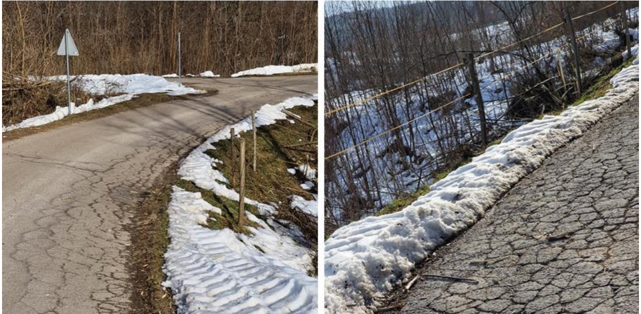
Slika 18. Puzanje bankine i procjeđivanje vode kroz bankinu
