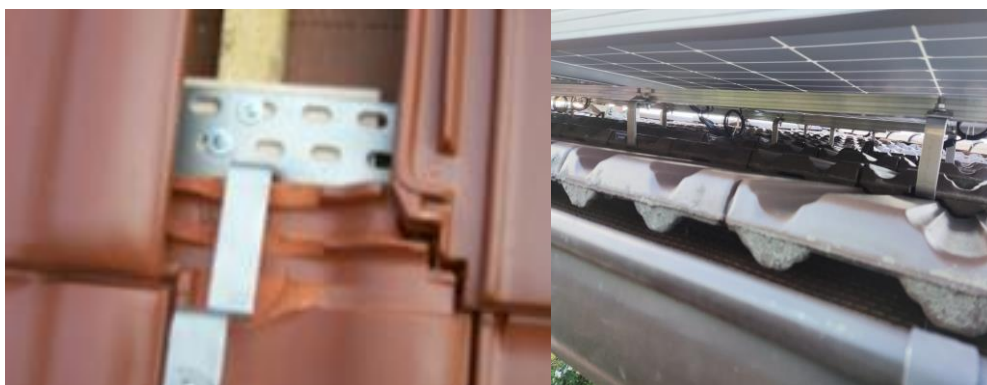
Slika 4.15. Detalj ugradnje krovnog nosača
