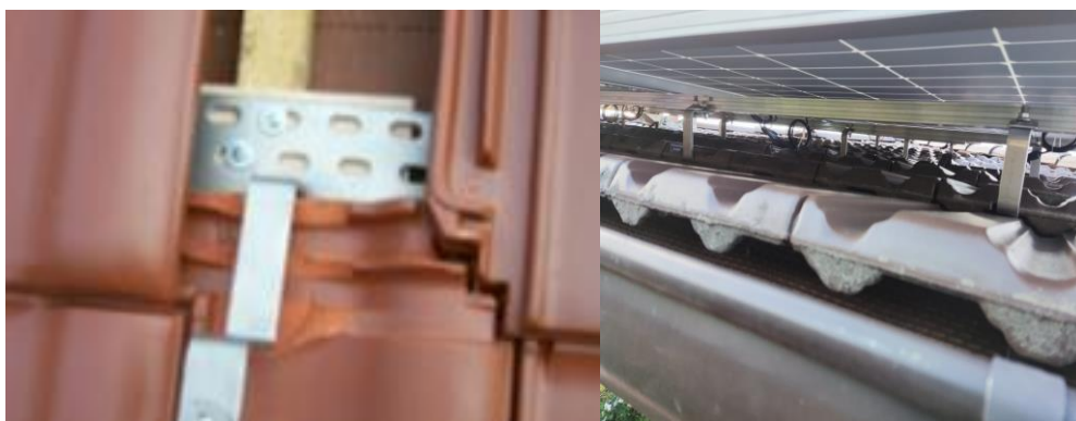
Slika 4.15. Detalj ugradnje krovnog nosača
