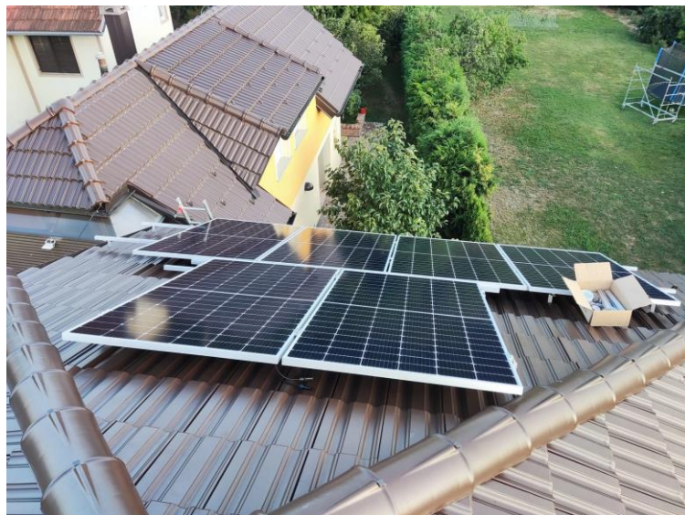
Slika 4.10. Faza montaže FN modula na krovnu površinu
