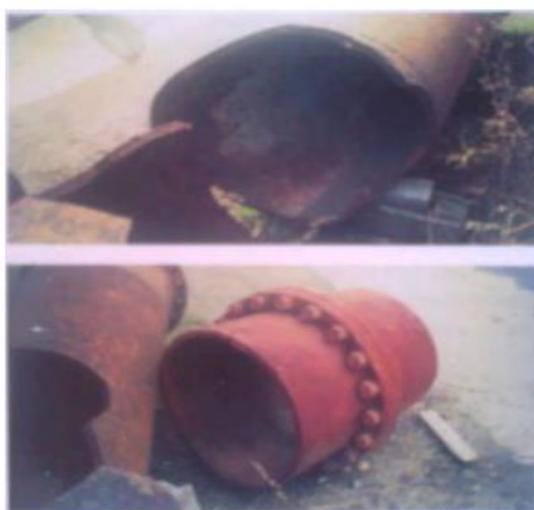
Slika 7.5. Izgleda cjevovoda nakon hidrauličkog udara [12]
