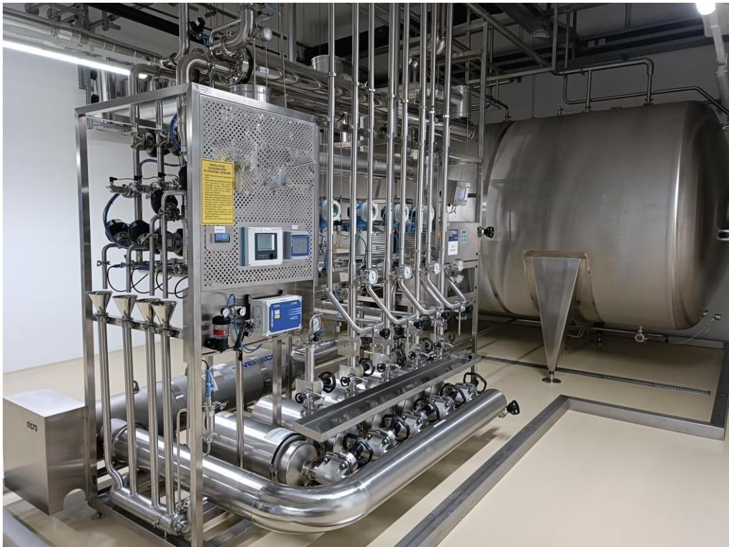
Slika 5. Spremnik i distribucija tehnološke vode (Izvor: Autor)
