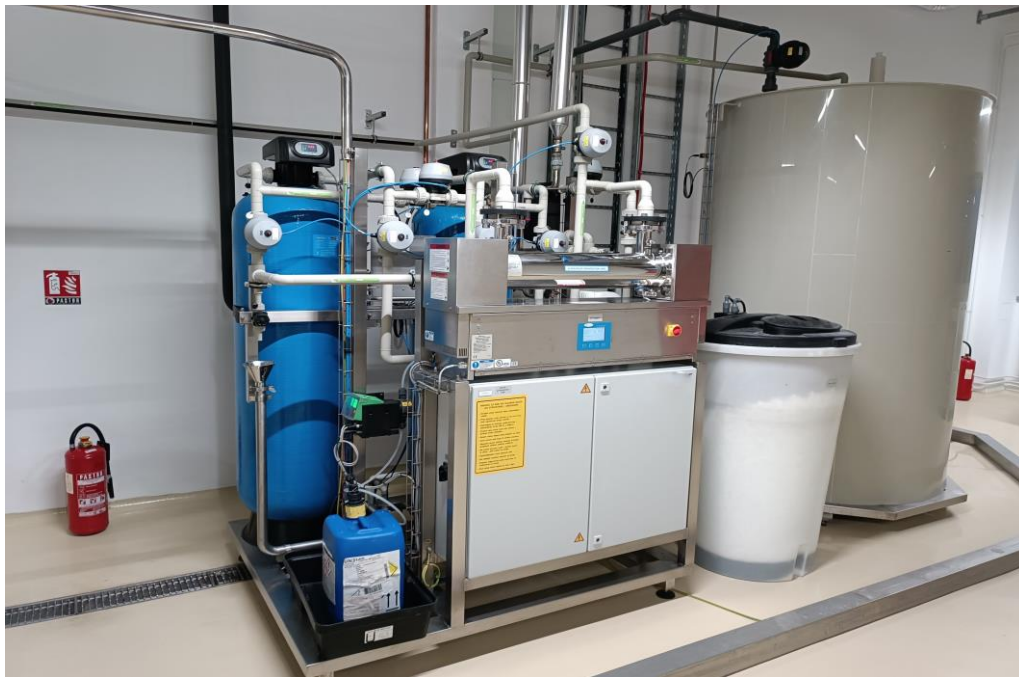
Slika 3. Predpriprema tehnološke vode (Izvor: Autor)
