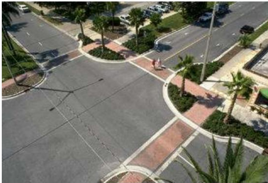
Slika 3-13 Primjer suženja vozne i proširenja pješačke površine
