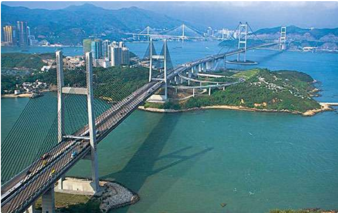
Slika 3a, Tsing Ma Bridge, izvor:
