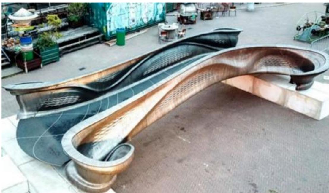
**Slika 16. Most izrađen WAAM postupkom [36]**
