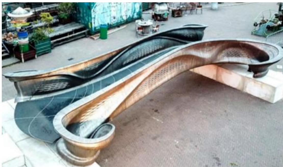
Slika 16. Most izrađen WAAM postupkom [36]
