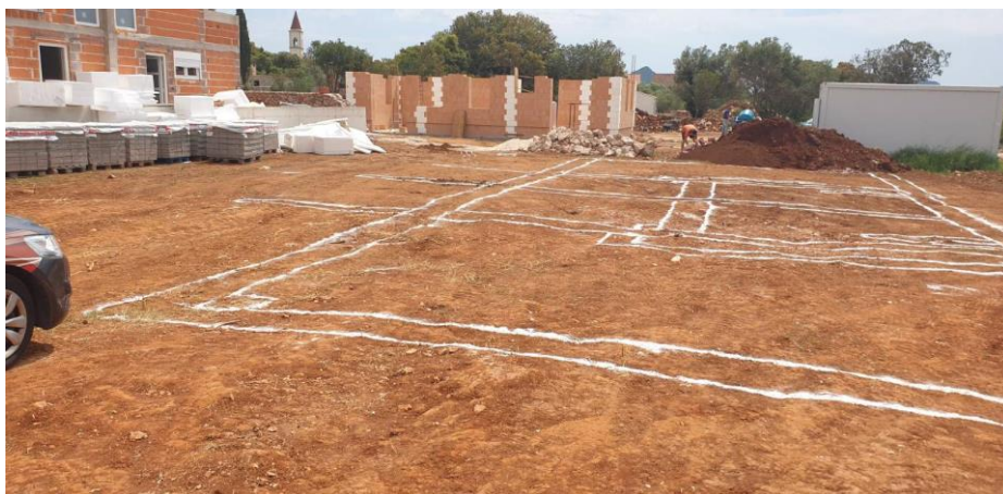
Slika.3.1.1 - Iscrtavanje temelja (iskolčenje)
