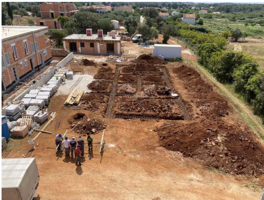
Slika 3.2.2. – Armatura nadtemeljnog zida
