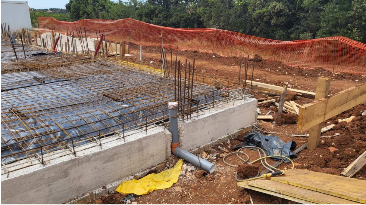
Slika 3.5.2. – Demontirana oplata (vidljiva lica betona)
