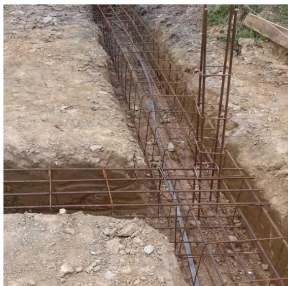
Slika 4.1. Armatura elastičnih temeljnih nosača na tlu
