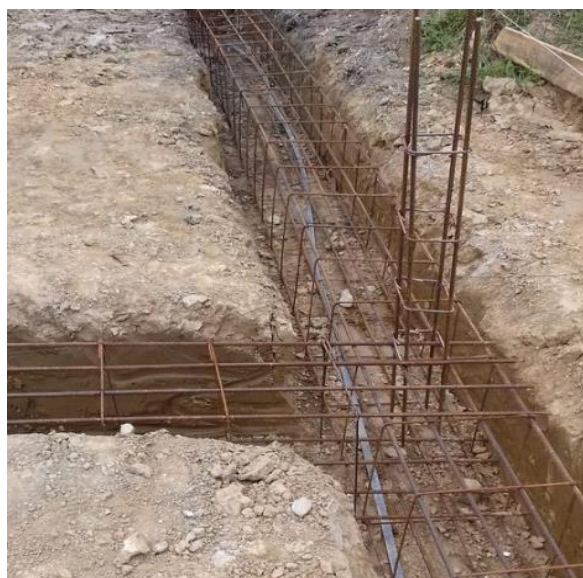
Slika 4.1. Armatura elastičnih temeljnih nosača na tlu
