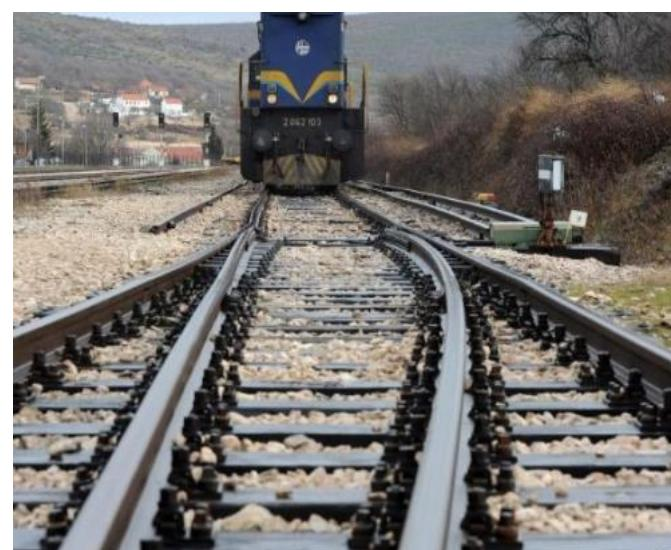
**Slika 3.5. Željeznička pruga- nosač na elastičnoj podlozi,**
