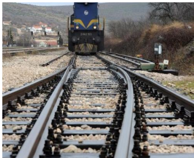
Slika 3.5. Željeznička pruga- nosač na elastičnoj podlozi,
