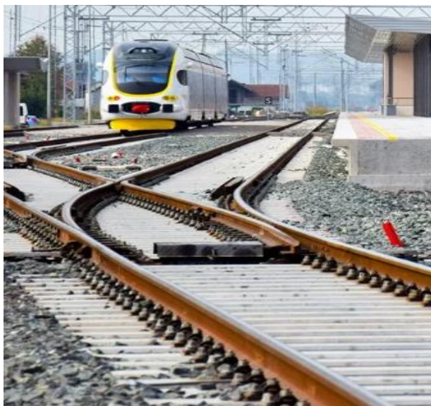
Slika 3.4. Željeznička pruga- nosač na elastičnoj podlozi,
