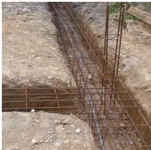
Slika 4.1. Armatura elastičnih temeljnih nosača na tlu
