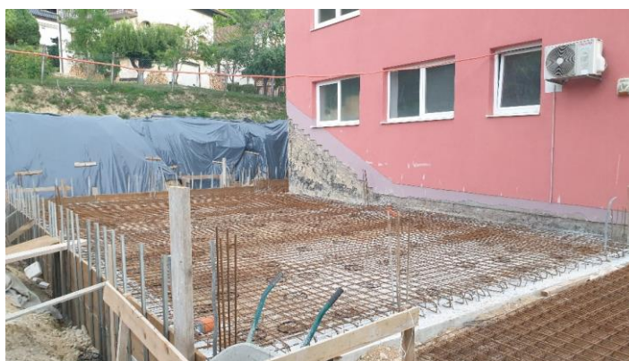
Slika. 3.3.1 Postavljena armaturna mreža za
