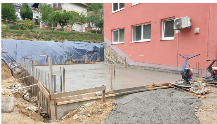
Slika 3.5.1. Prikazuje betoniranje AB podne ploče
