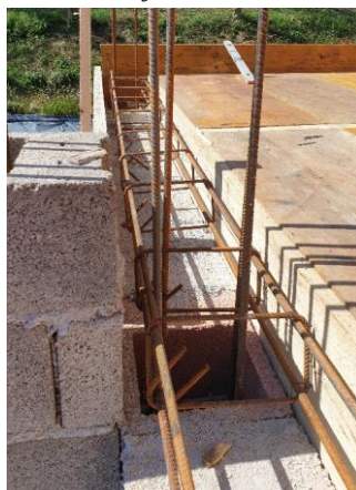
Slika. 3.3.2 Armatura za vertikalne i horizontalne serklaže
