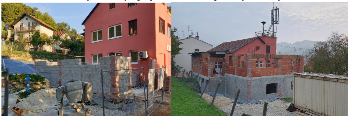
Slika 3.4.1 i 3.4.2. Prikazuju proces zidarskih radova
