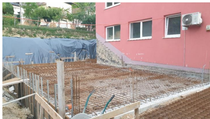
Slika. 3.3.1 Postavljena armaturna mreža za
