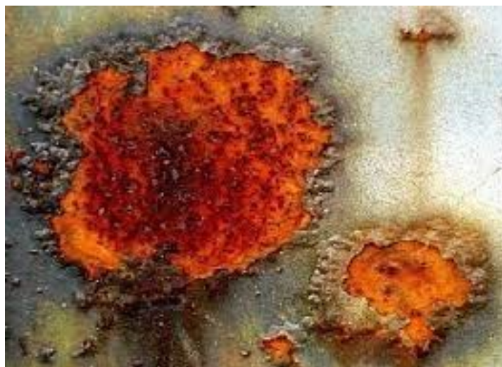
Slika 2.9. Prikaz potpovršinske korozije [11]
