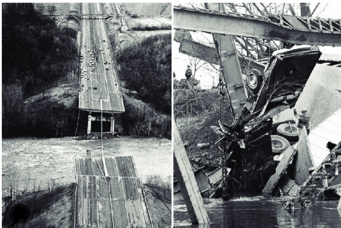
Slika 2.1. Srušeni most „Silver Brigde“ u Ohio-u [5]
