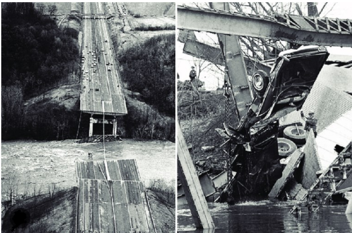
Slika 2.1. Srušeni most „Silver Brigde“ u Ohio-u [5]
