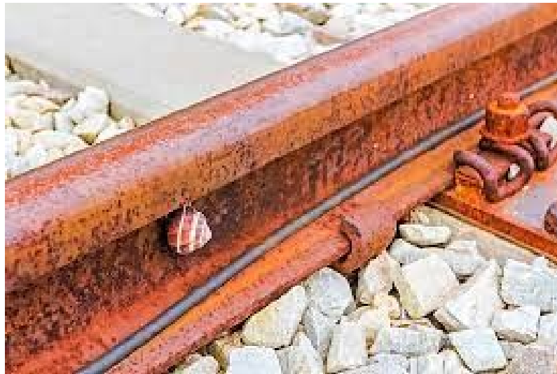
Slika 2.5. Prikaz opće korozije [7]
