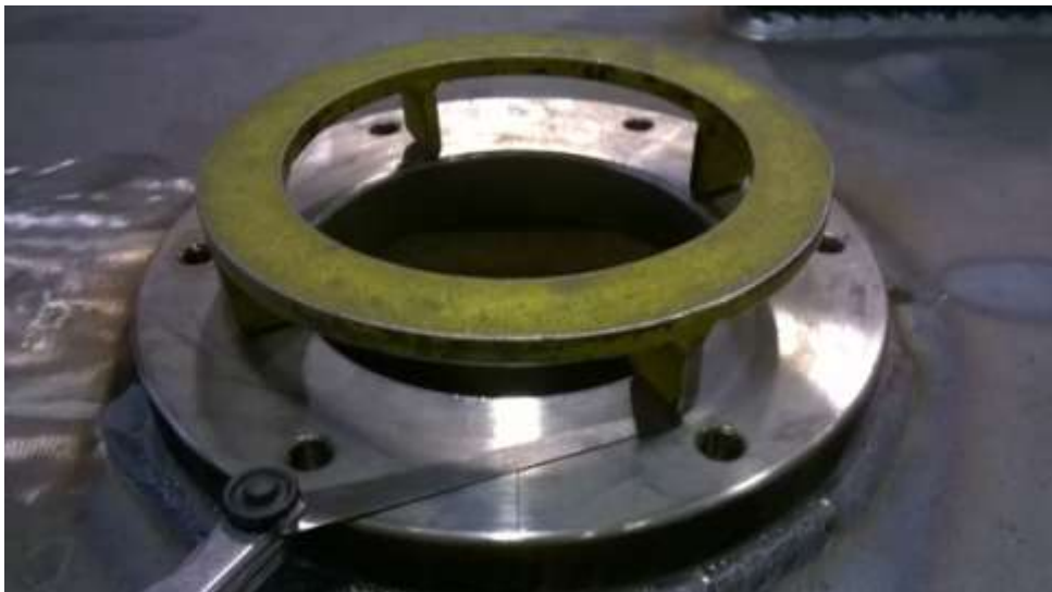
Slika 5.1: Kontrola brtvi s napravom i listićima za ispitivanje zračnosti
