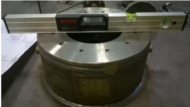
Slika 4.69: Kontrola ravnosti kupola s prirubnicom visoko naponske strane
