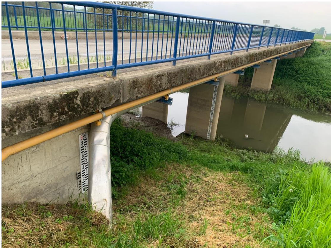
Slika 4.3. Rijeka Karašica na lokaciji u Kapelni [25]
