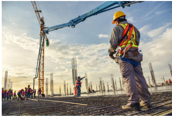
Slika 5. Provedba radova na gradilištu (izvor: web)
