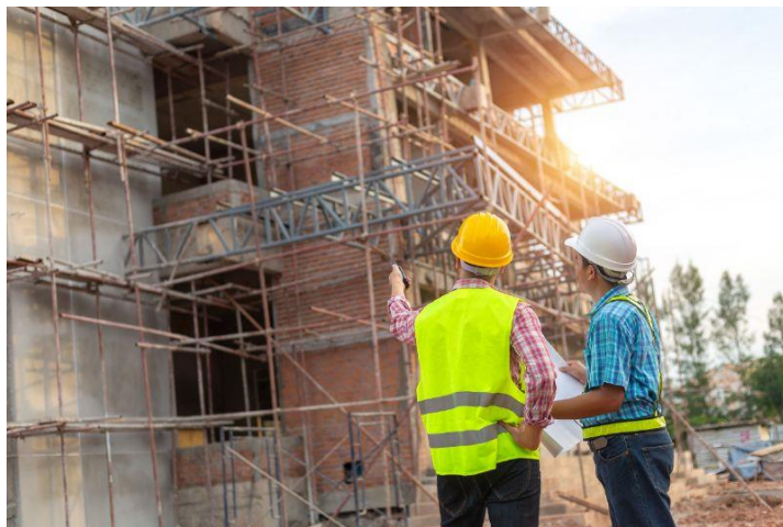
Slika 4. Nadzor na gradilištu (izvor: web)
