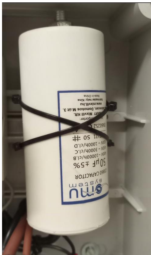
Slika 3.2.1. Kondenzator
