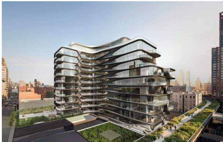
Slika 3.3 Prikaz scene virtualne stvarnosti zgrade „520 West 28th Street“ u New Yorku
