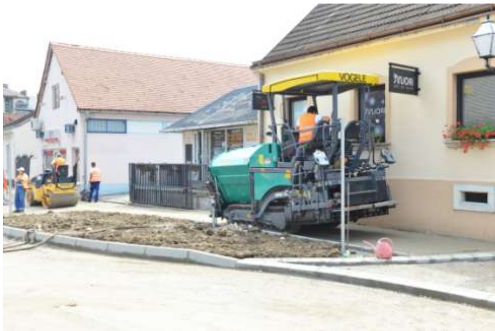
Slika 21. Ugradnja i zbijanje asfaltne mase (Izvor: PZC Varaždin d.d., arhiva fotografija, 2013.)
