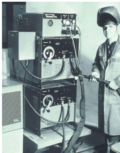
Slika 2.1. Radnik s plazma opremom 1957. godine [5]
