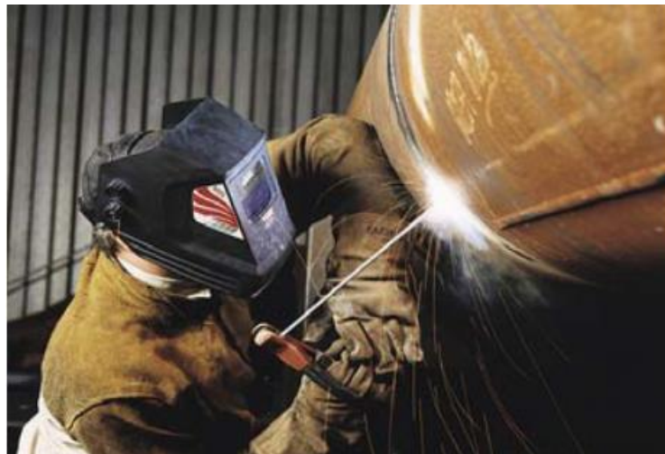
Slika 2.1. Primjer REL zavarivanja [2]
