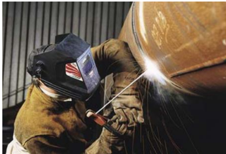
Slika 2.1. Primjer REL zavarivanja [2]
