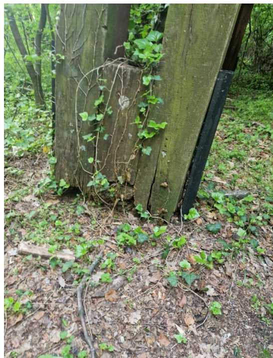
Slika 10.14. Spoj konstrukcije vidikovca i armirano-betonskih temelja
