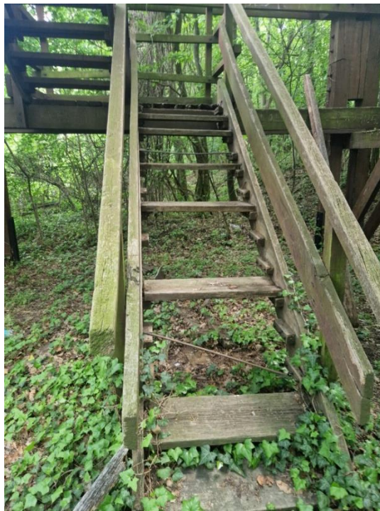
Slika 10.11. Dotrajali dijelovi vidikovca – ulazne stepenice
