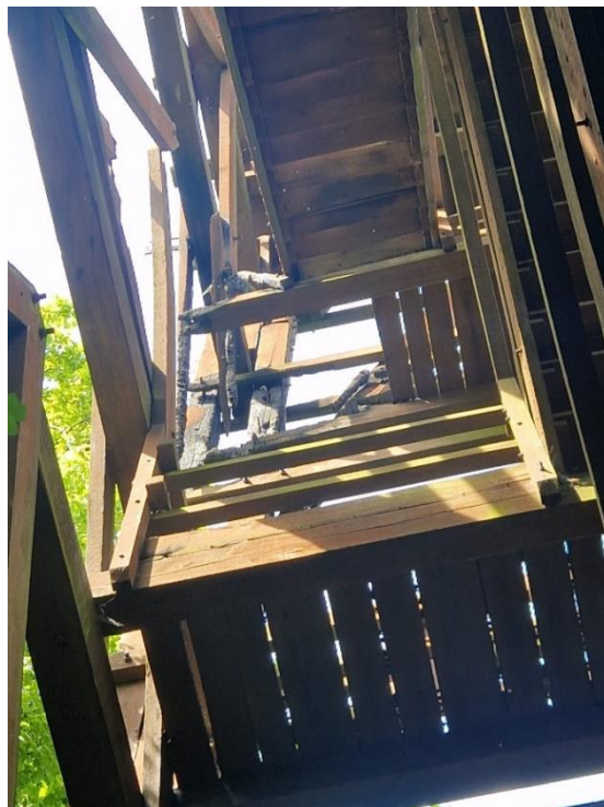
Slika 10.10. Dotrajali dijelovi vidikovca – izgoreni dijelovi
