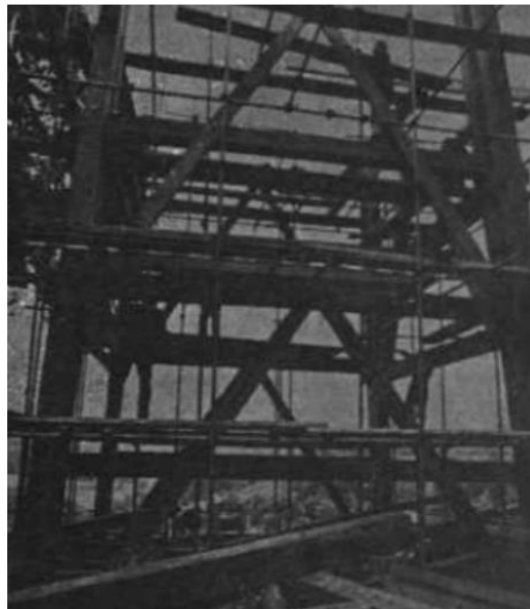
Slika 10.2. Vidikovac u tijeku izgradnje
