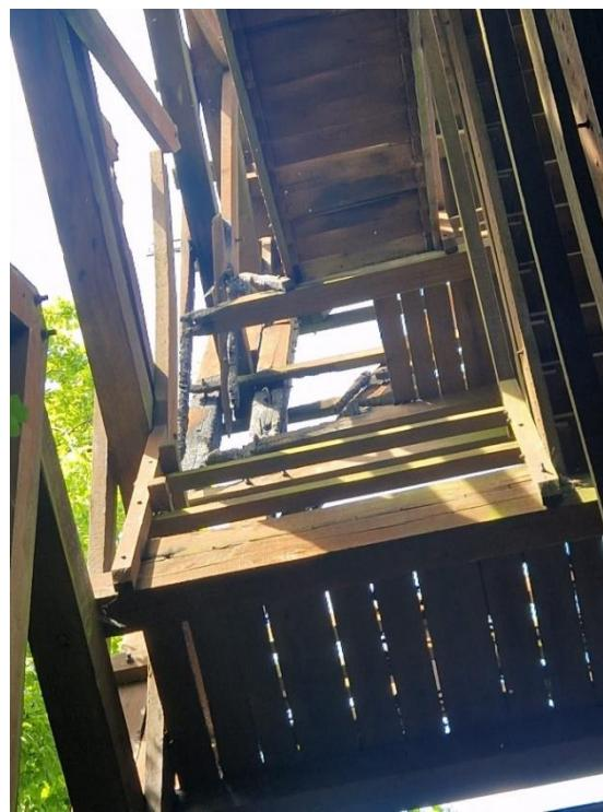
*Slika 10.10. Dotrajali dijelovi vidikovca – izgoreni dijelovi*
