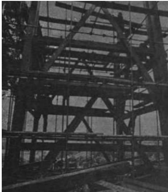
Slika 10.2. Vidikovac u tijeku izgradnje
