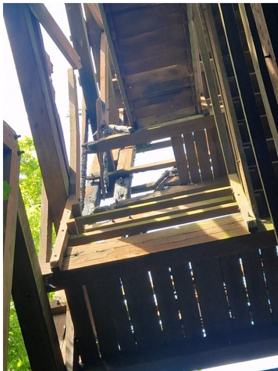
Slika 10.10. Dotrajali dijelovi vidikovca – izgoreni dijelovi
