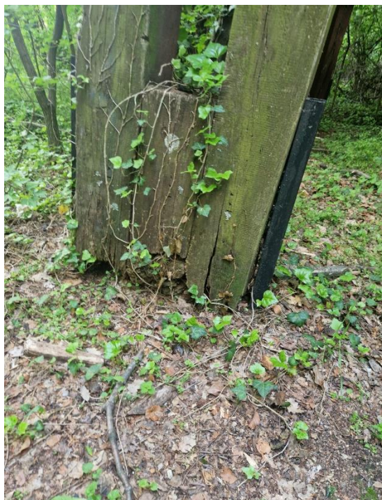
Slika 10.14. Spoj konstrukcije vidikovca i armirano-betonskih temelja
