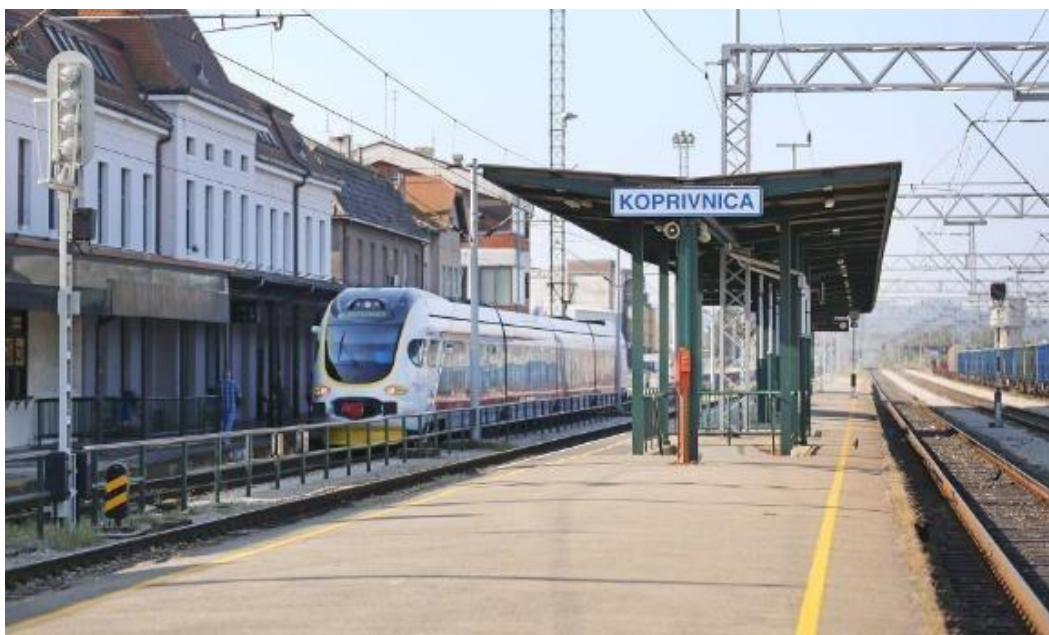
Slika 64 Željeznički kolodvor u gradu Koprivnici
