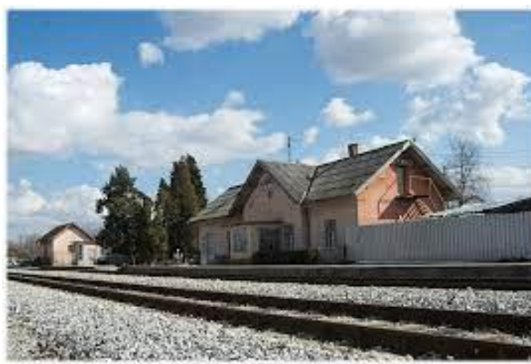
Slika 47 Željeznički kolodvor Cerje Tužno
