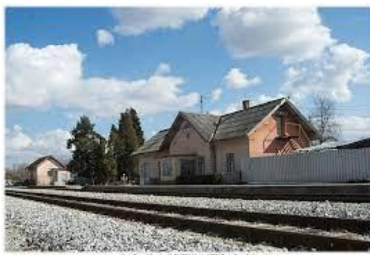
Slika 47 Željeznički kolodvor Cerje Tužno
