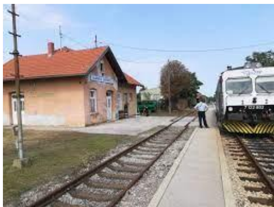
Slika 29 Željeznički kolodvor u gradu Mursko Središće
