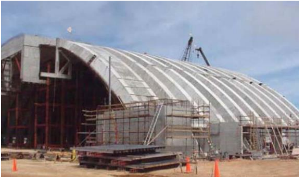
Slika 1.4. Hangar za održavanje zrakoplova u Guamu
