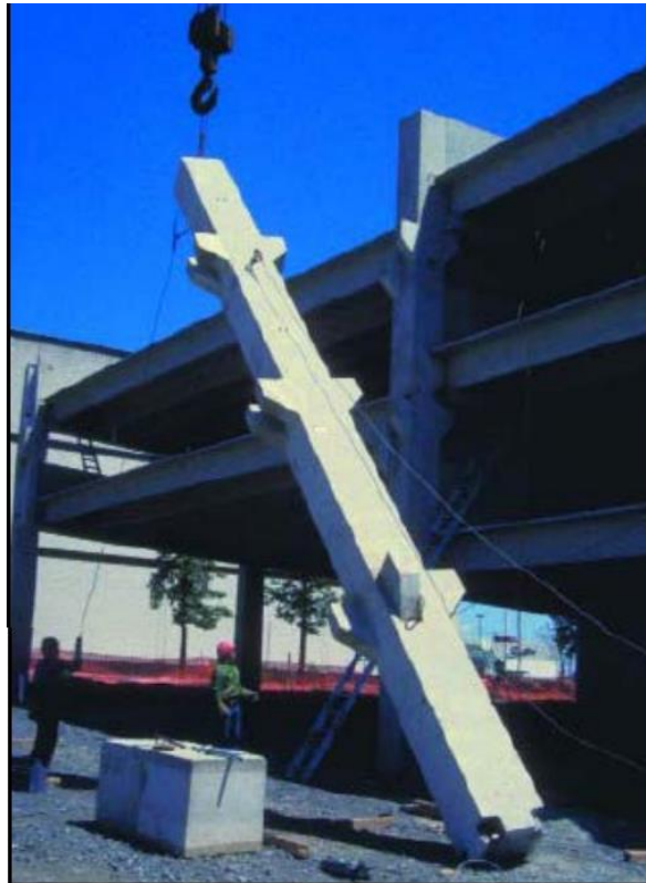
Slika 1.1. Predgotovljeni AB stup
