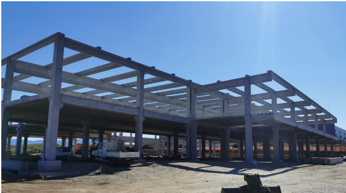
Slika 1.6. AB montažna konstrukcija
