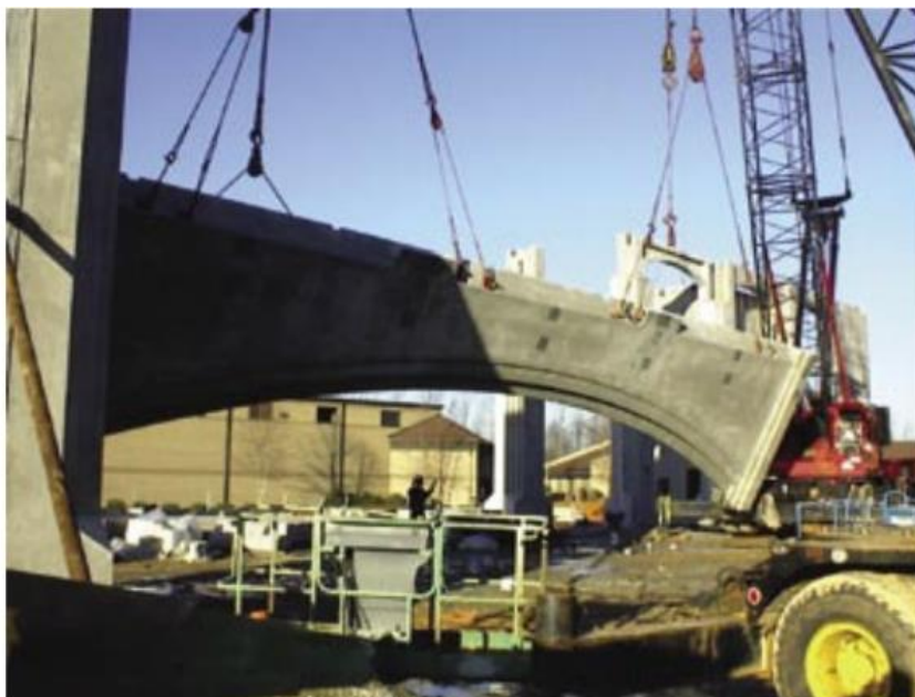
Slika 1.8. Predgotovljeni element crkve „Prince of Peace“ Taylors u Južnoj Karolini u SAD - u
