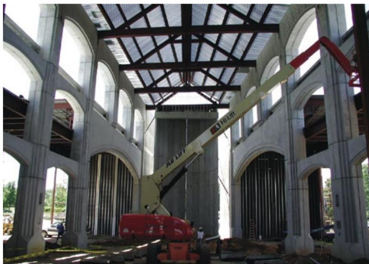
Slika 2.7. Čelična krovna konstrukcija crkve „Prince of Peace“ Taylors u Južnoj Karolini u SAD - u
