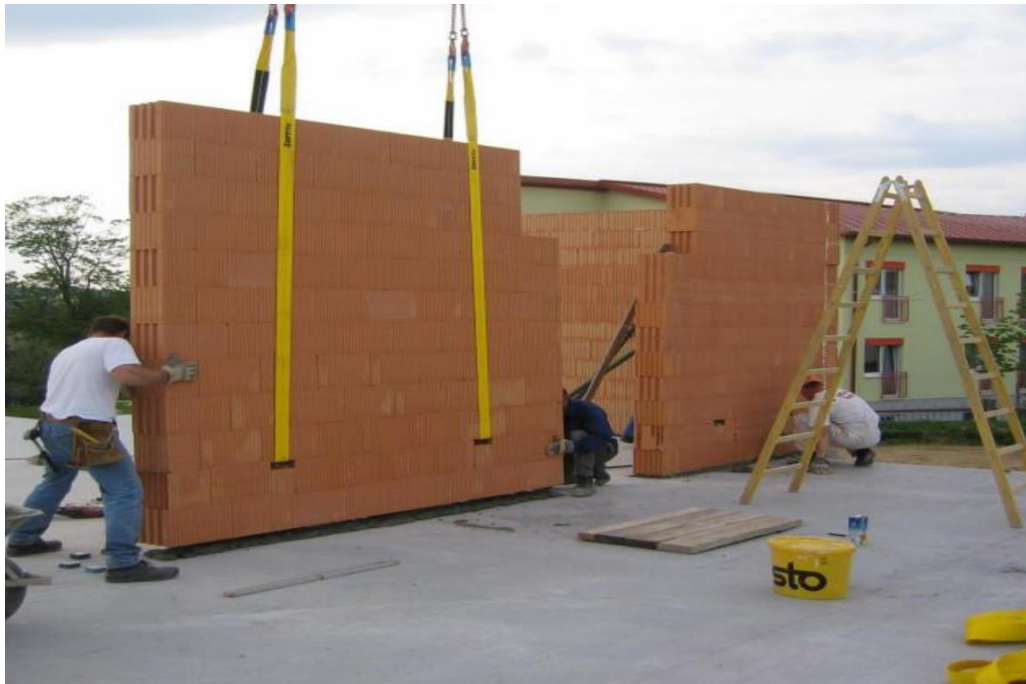
Slika 7.3. Montaža predgotovljenog zidnog opečnog elementa
