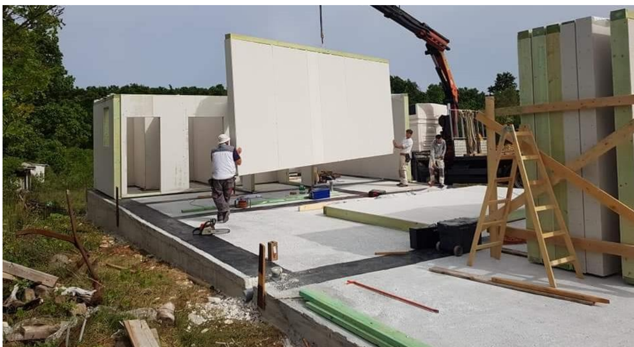
Slika 1. Gradnja montažne kuće
