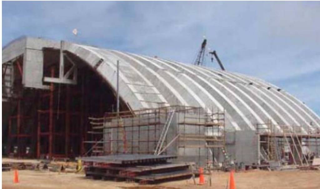
Slika 1.4. Hangar za održavanje zrakoplova u Guamu
