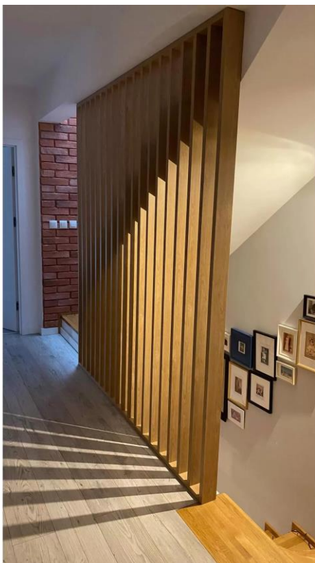
Slika 3.6. Pregradni element od drvenih letvica
