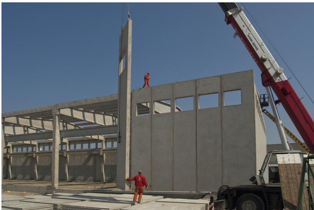
Slika 1.7. Montaža predgotovljenih panela
