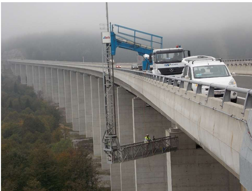
Slika 11: Vizualni pregled mosta uz pomoć posebne opreme – dizalice ( http://geoexpert-igm.hr/certifikacija/ob-poc-7-ag-03_cert-shema-ag-mort_izd-2/ )
