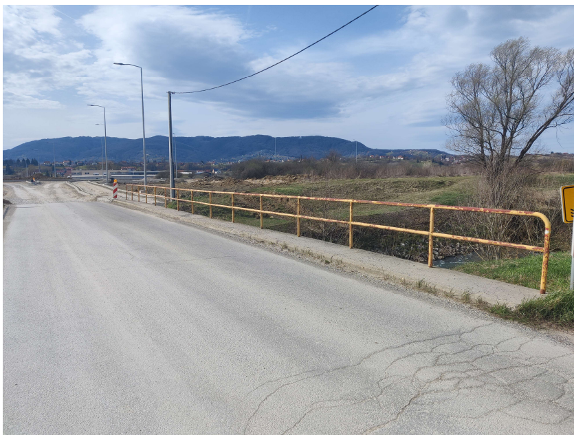
Slika 21: Oštećenje kolničkog zastora (autorski rad)
