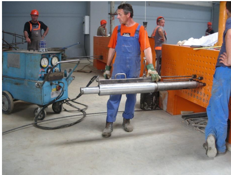
Slika 2.6 Hidraulička preša za zatezanje
