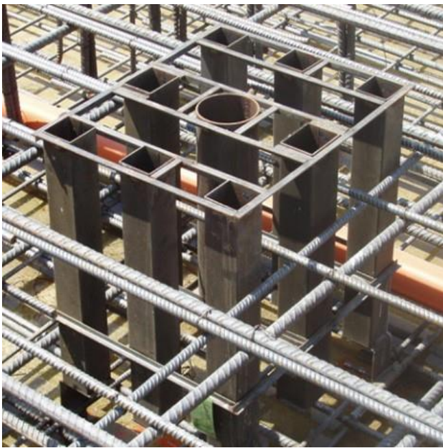
Slika 2.12 Čelične cijevi (lijevo) i spajanje stupa i temelja (desno) [5]
