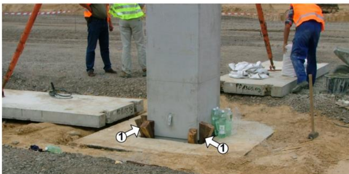
Slika 3.11 Poravnavanje stupa nakon sastavljanja u čašicu upotrebom drvenih klinova (3.9 - 1) [4]
