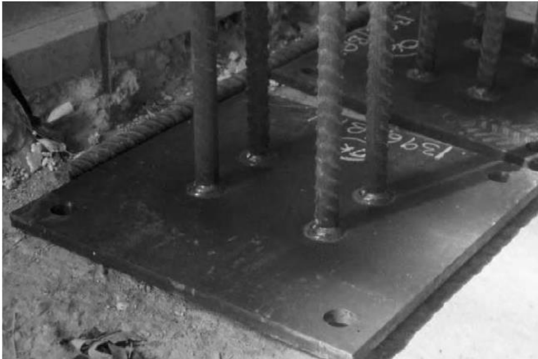
Slika 2.6 Čelična ploča prije ugradnje [1]
