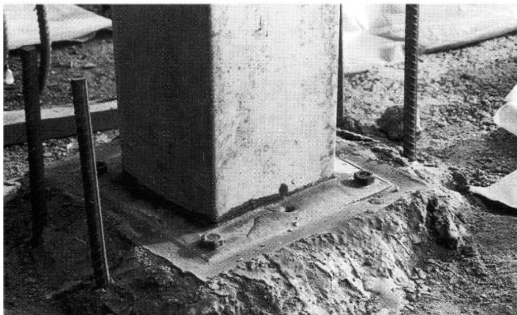
Slika 2.7 Prikaz stupa temeljenog na čeličnoj podnožnoj ploči [2]
