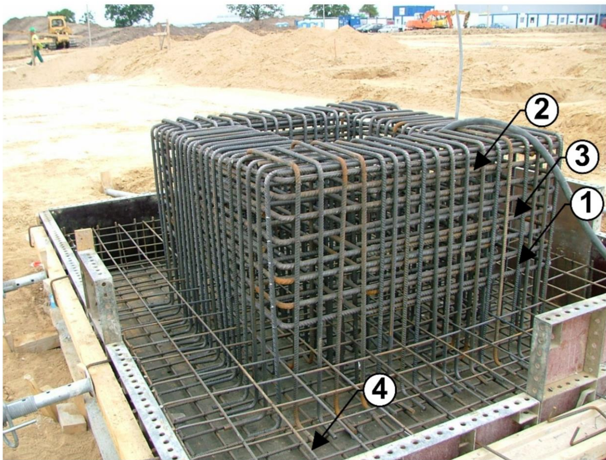
Slika 3.3 Prikaz armature temeljne stope i čaše [4]
