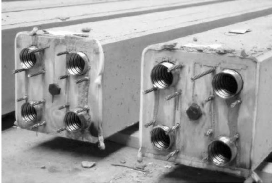
Slika 2.10 Čelični rukavi [1]
