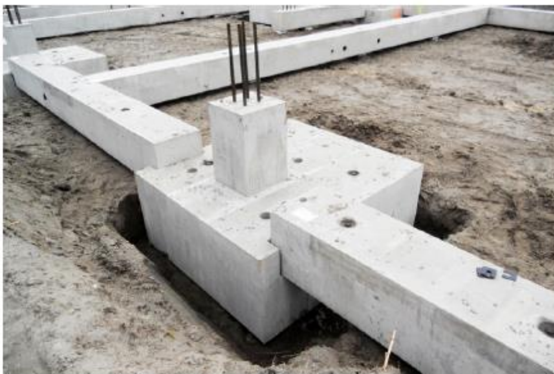
Slika 4.2 Izvedba na gradilištu [11]
