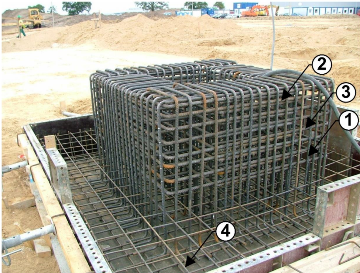
Slika 3.3 Prikaz armature temeljne stope i čaše [4]
