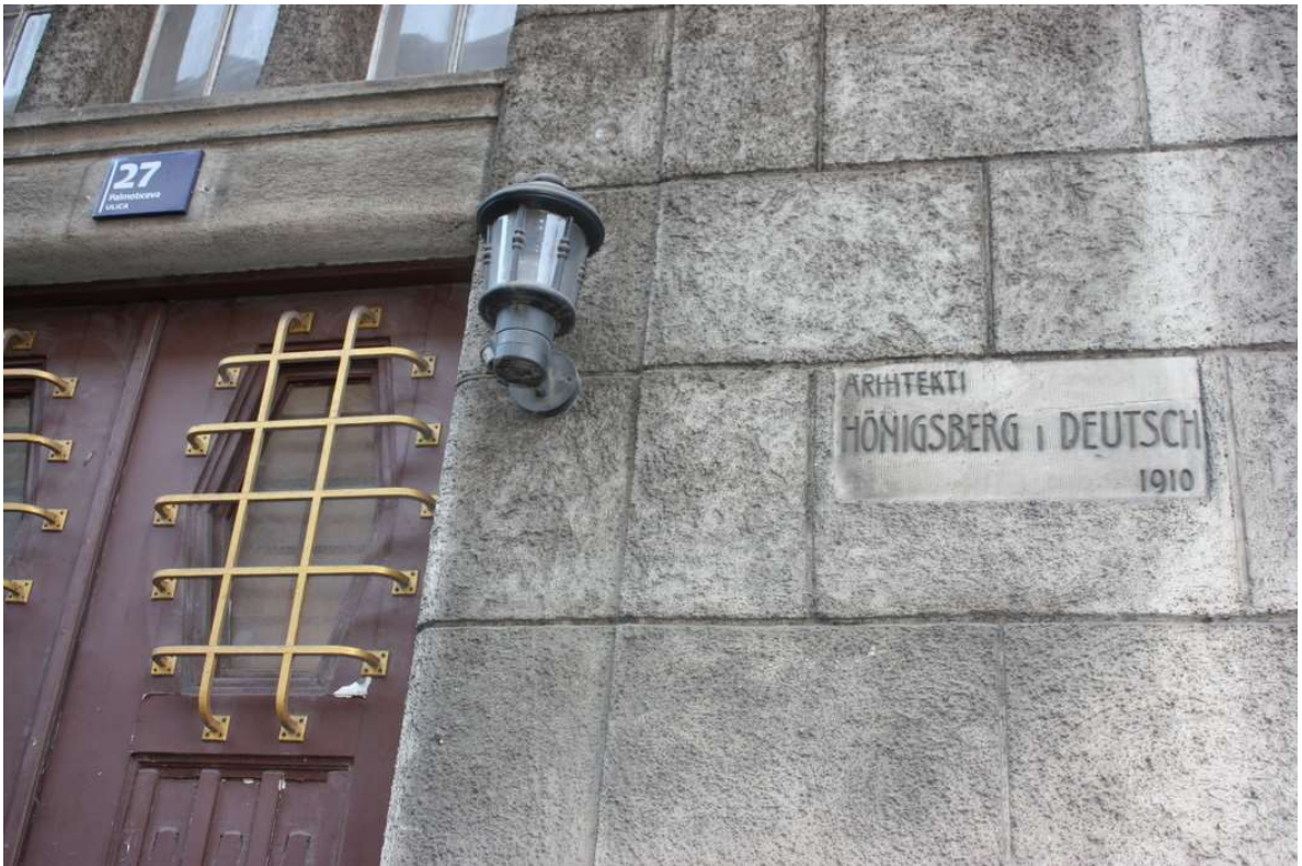
Slika 2.2 Ploča s godinom gradnje te projektnim uredom kod ulaza u zgradu [1]
