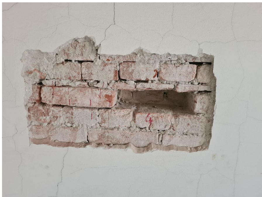
Slika 6. Prikaz uklonjene opeke prije početka ispitivanja
