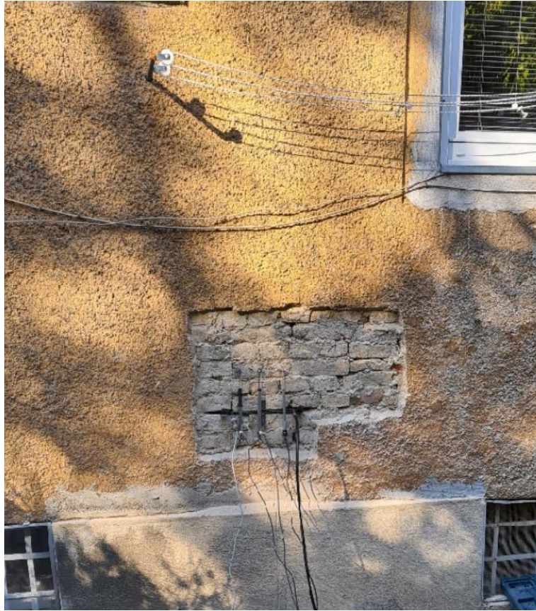
Slika 25. Ispitivanje na poziciji T-1
