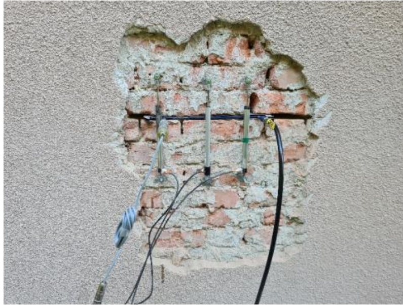
Slika 18. Određivanje postojećeg tlačnog naprezanja u zidu
