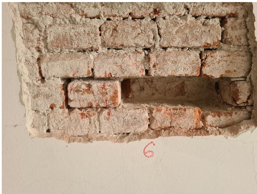
Slika 7. Prikaz uklonjene opeke prije početka ispitivanja
