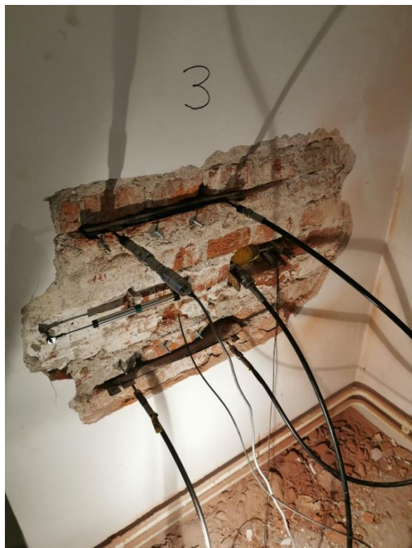
Slika 20. Ispitivanje posmične čvrstoće uz kontrolu vertikalnog naprezanja
