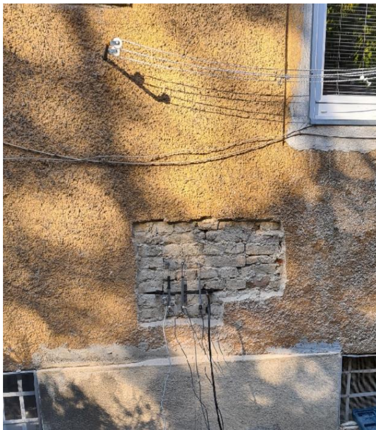
Slika 17. Određivanje postojećeg tlačnog naprezanja u zidu
