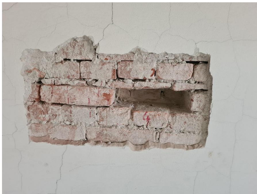
Slika 6. Prikaz uklonjene opeke prije početka ispitivanja
