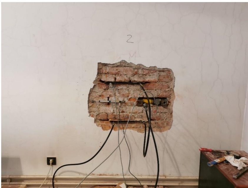
Slika 21. Ispitivanje posmične čvrstoće uz kontrolu vertikalnog naprezanja
