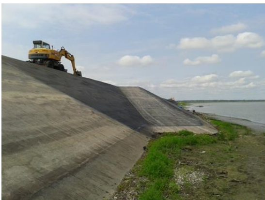
Slika 64. Izvedeni novi vodonepropusni asfaltni sloj na dijelu ulazno - silazne rampe
