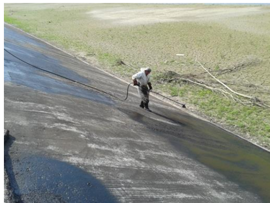
Slika 45. Špricanje polimerne bitumenske kationske emulzije na pripremljenu podlogu
