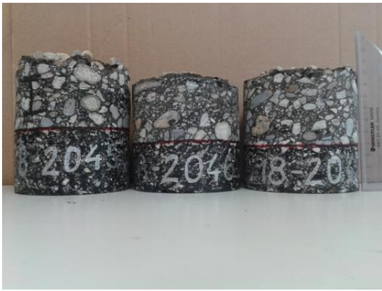
Slika 60. Izvađeni uzorci iz ugrađenog asfaltnog sloja (vodonepropusni + nosivi sloj)
