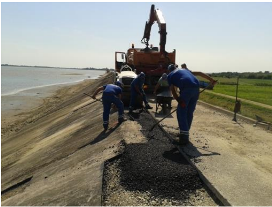
Slika 42. Ugradnja asfaltne mješavine - priprema podloge za vodonepropusni asfaltni sloj
