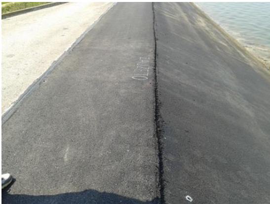
Slika 80. Detalj zapunjenog uzdužnog radnog spoja na kruni nasipa
