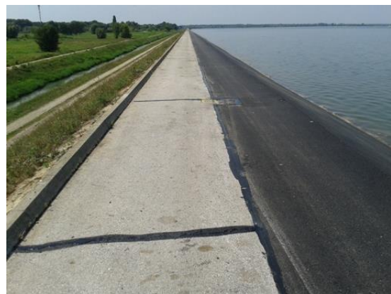
Slika 83. Detalj završenih radova na zamjeni nosivo-habajućeg asfaltnog sloja na kruni nasipa š=1,6 m
