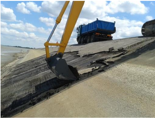
Slika 24. Uklanjanje oštećene asfalt-betonske obloge struganjem korpom bagera (donja zona)
