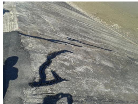
Slika 41. Sanirane strukturne pukotine
