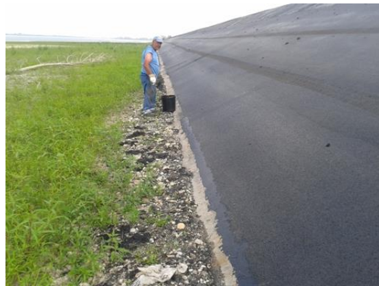
Slika 75. Ugradnja hladne bitumenske polimerne mase na uzdužnom spoju na dnu zahvata
