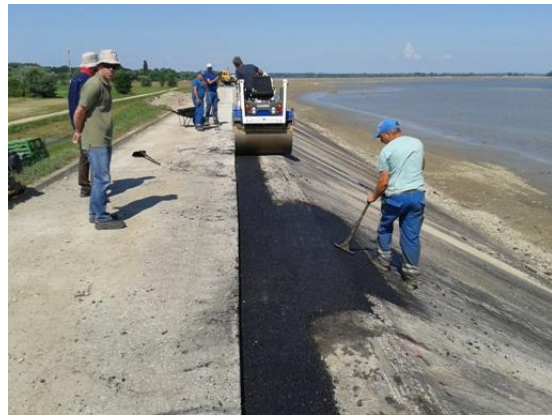
Slika 43. Zbijanje asfalta na kruni nasipa - priprema podloge za vodonepropusni asfaltni sloj
