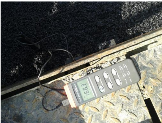
Slika 50. Mjerenje temperature asfaltne mješavine kod puža finišera
