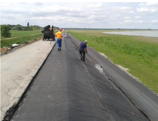
Slika 70. Špricanje uzdužnog radnog spoja polimernom bitumenskom emulzijom
