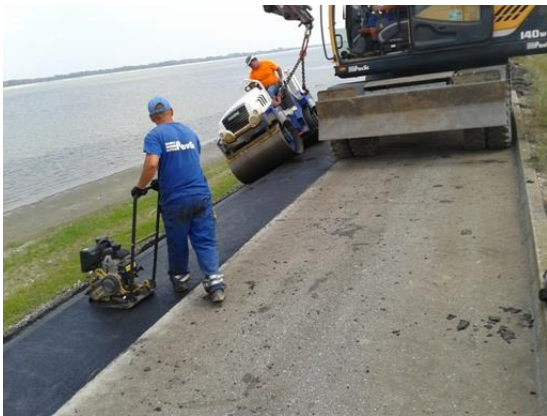
Slika 74. Zbijanje asfaltne mješavine vodoneprop. asfaltnog sloja na kosini i kruni nasipa
