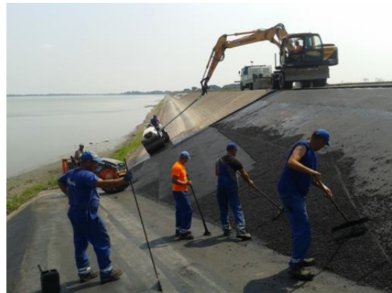
Slika 63. Izvedba novog vodonepropusnog asfaltnog sloja na dijelu ulazno - silazne rampe
