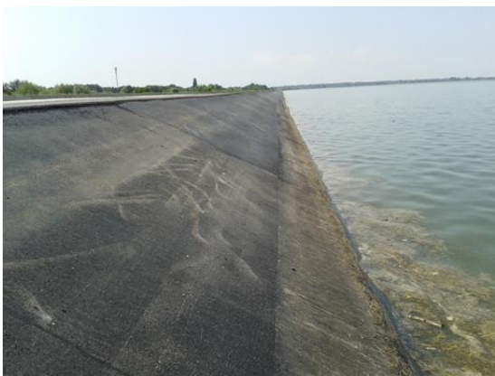
Slika 82. Detalj završenih radova na zamjeni asfalt-betonske obloge kosine nasipa (pri radnoj koti vodostaja akumulacije)
