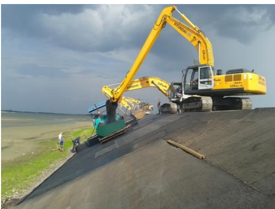
Slika 52. Doziranje asfaltne mješavine u sanduk finišera pomoću „korpe“ bagera
