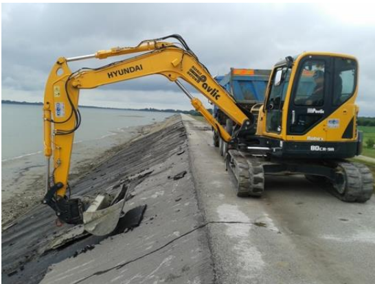
Slika 26. Uklanjanje oštećene asfalt-betonske obloge struganjem korpom bagera (gornja zona)
