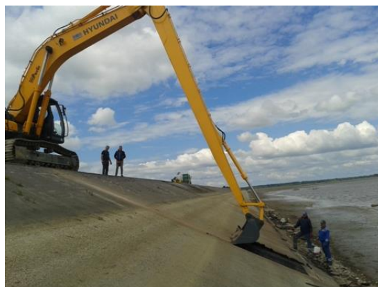
Slika 23. Uklanjanje oštećene asfalt-betonske obloge struganjem korpom bagera (donja zona)
