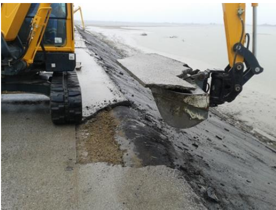
Slika 28. „Otvaranje“ detalja podvučenog vodonepropusnog sloja na kruni nasipa
