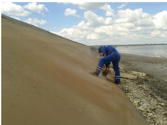
Slika 20. Zarezivanje uzdužnog „šlica“ na granici zahvata
