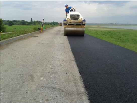
Slika 78. Zbijanje nosivo - habajućeg asfaltnog sloja na kruni nasipa (š=1,6 m)
