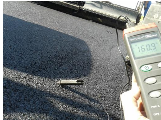
Slika 51. Mjerenje temperature asfaltne mješavine u sloju (neposredno iza finišera)
