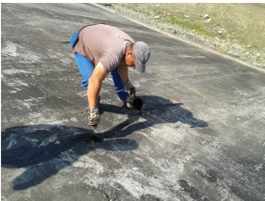
Slika 40. Zapunjavanje strukturnih pukotina vrućom polimernom bitumenskom masom
