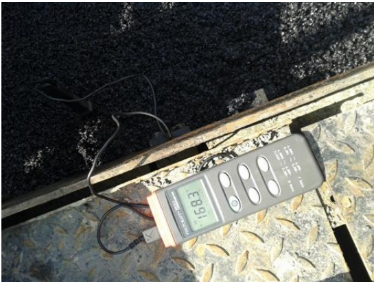
Slika 50. Mjerenje temperature asfaltne mješavine kod puža finišera
