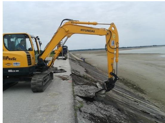
Slika 27. Uklanjanje oštećene asfalt-betonske obloge struganjem korpom bagera (gornja zona)
