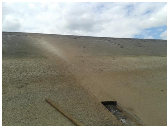
Slika 21. Zarezivanje poprečnog „šlica“
