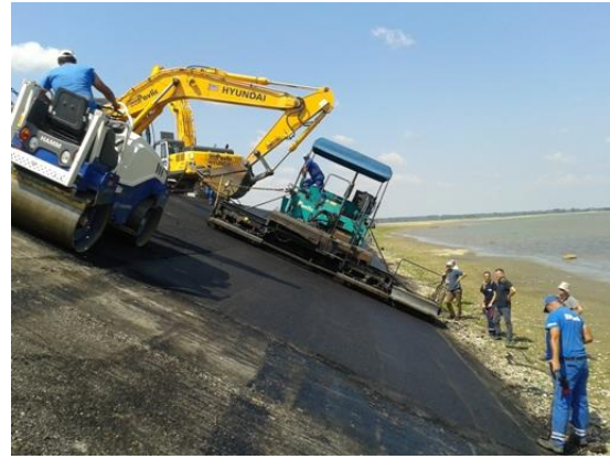
Slika 49. Ugradnja asfaltne mješavine vodoneprop. sloja obloge nasipa finišerom (donja zona)
