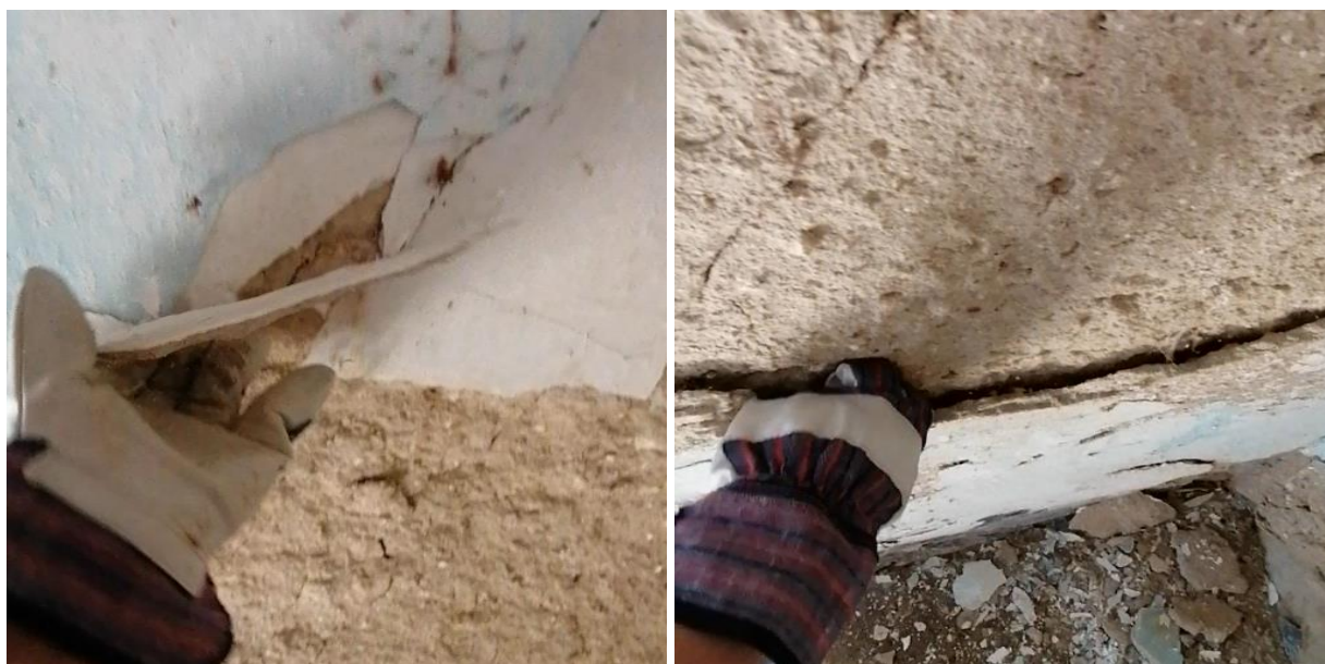
Slika 5.8: Skidanje žbuke s unutarnjih zidova
