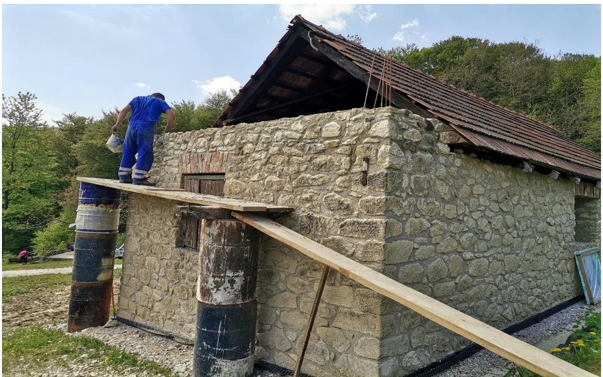
Slika 5.35: Ugradnja betona i improvizacija skele (istočna strana)
