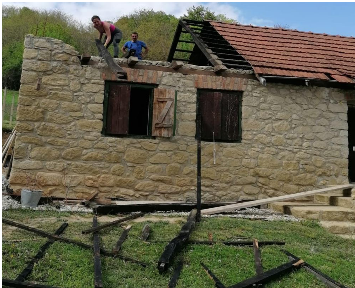
Slika 5.71: Segmentno rušenje krova
