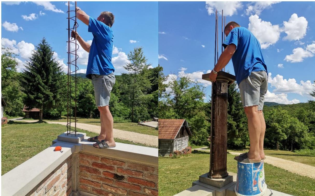
Slika 5.100: Izrada betonskog stupa – ugradnja armature i kalupa
