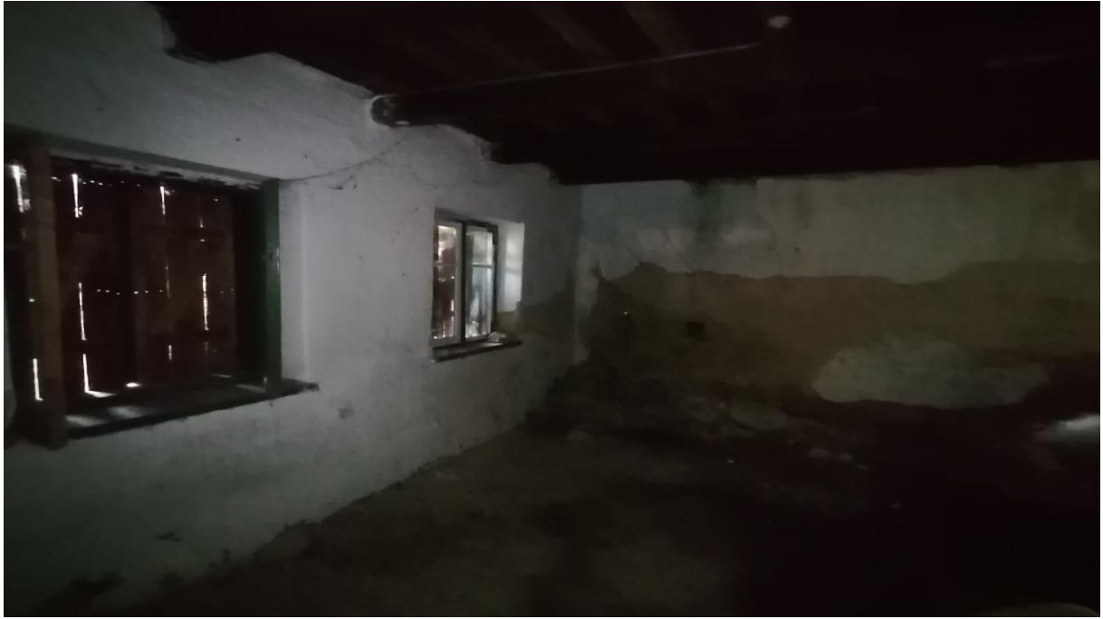
Slika 3.17: Stanje unutrašnjih zidova – prostorija 1
