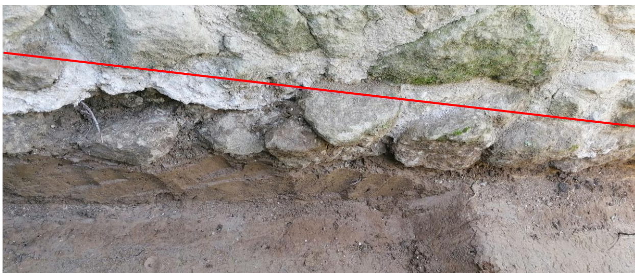
Slika 3.10: Iskop uz temelje
