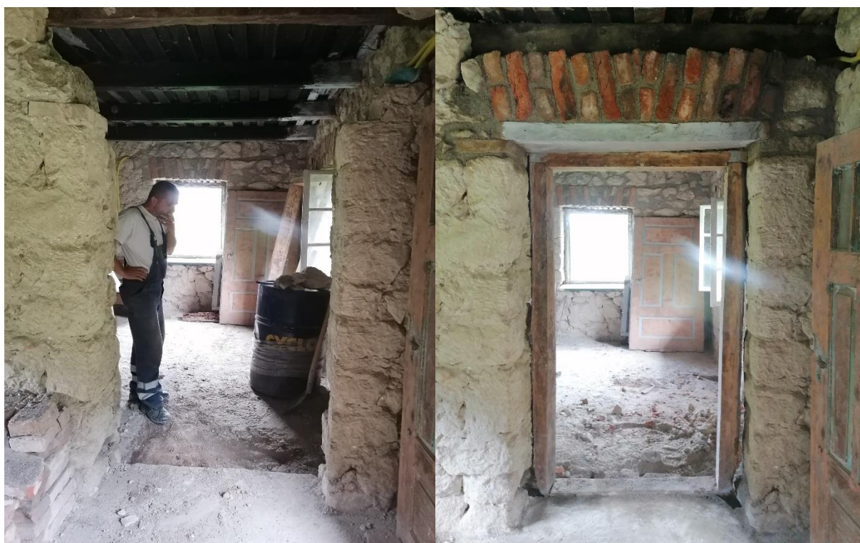
Slika 5.65: Rušenje nadvoja iznad sobnih vrata
