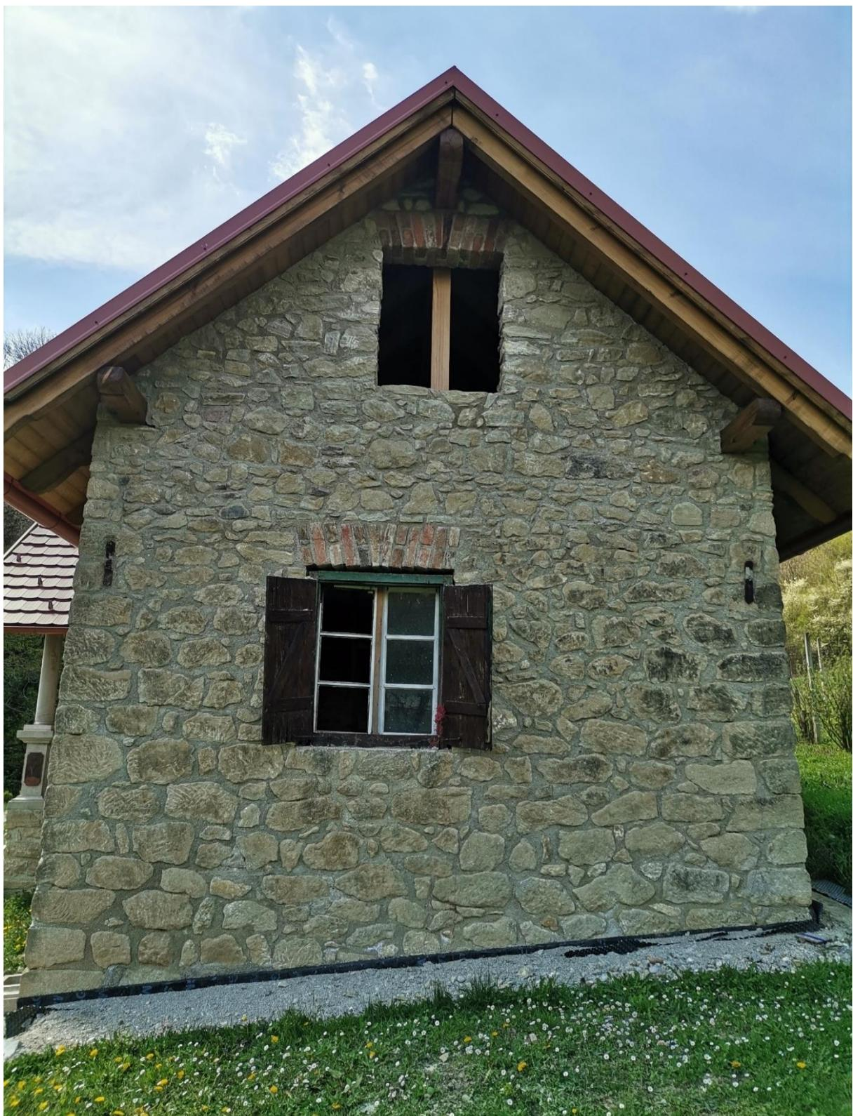
*Slika 5.68: Prikaz konačnog izgleda nadvoja od opeke (donji prozor) i nadvoja od armiranog betona i opeke (gornji prozor)*
