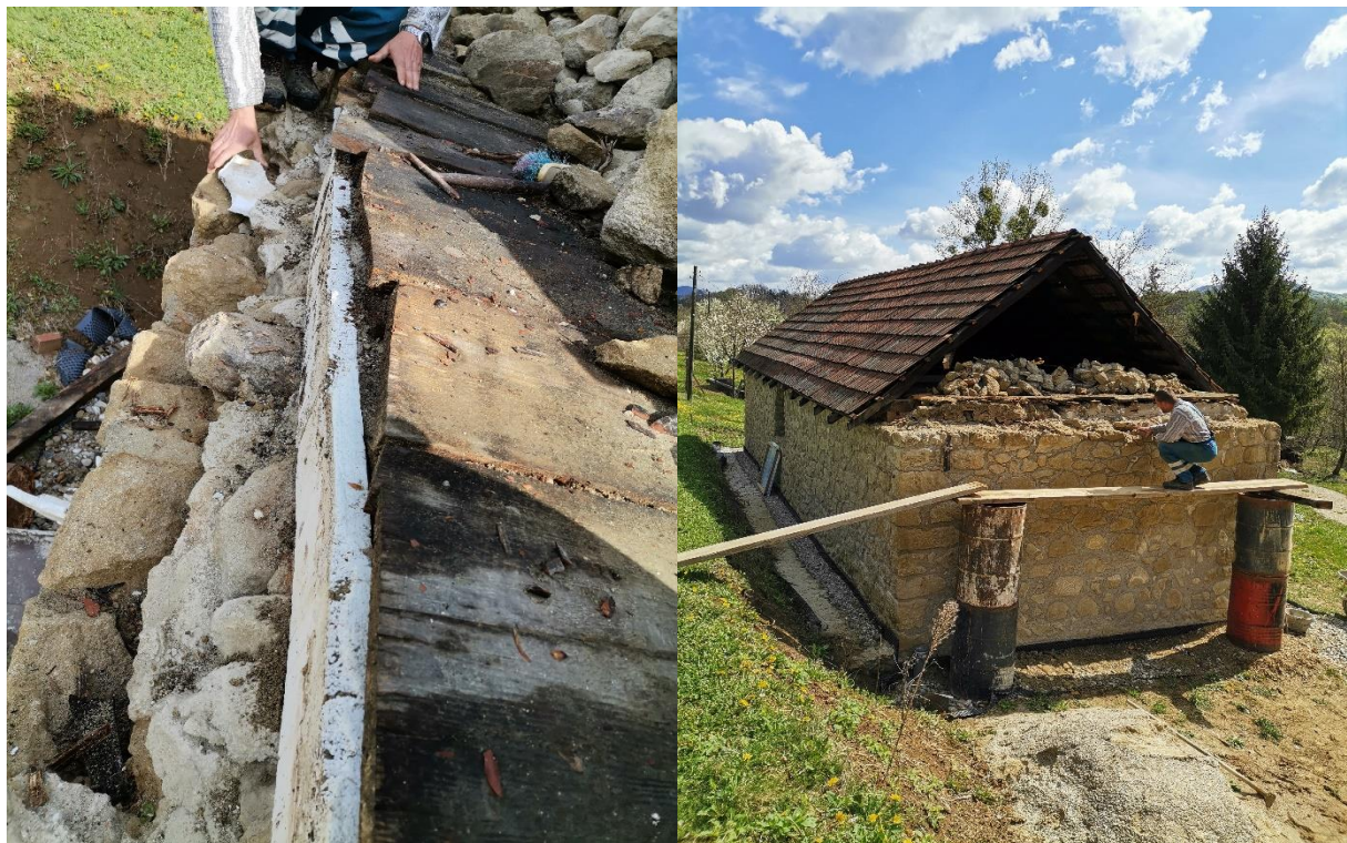
Slika 5.31: Uklanjanje grede u zabatnom zidu
