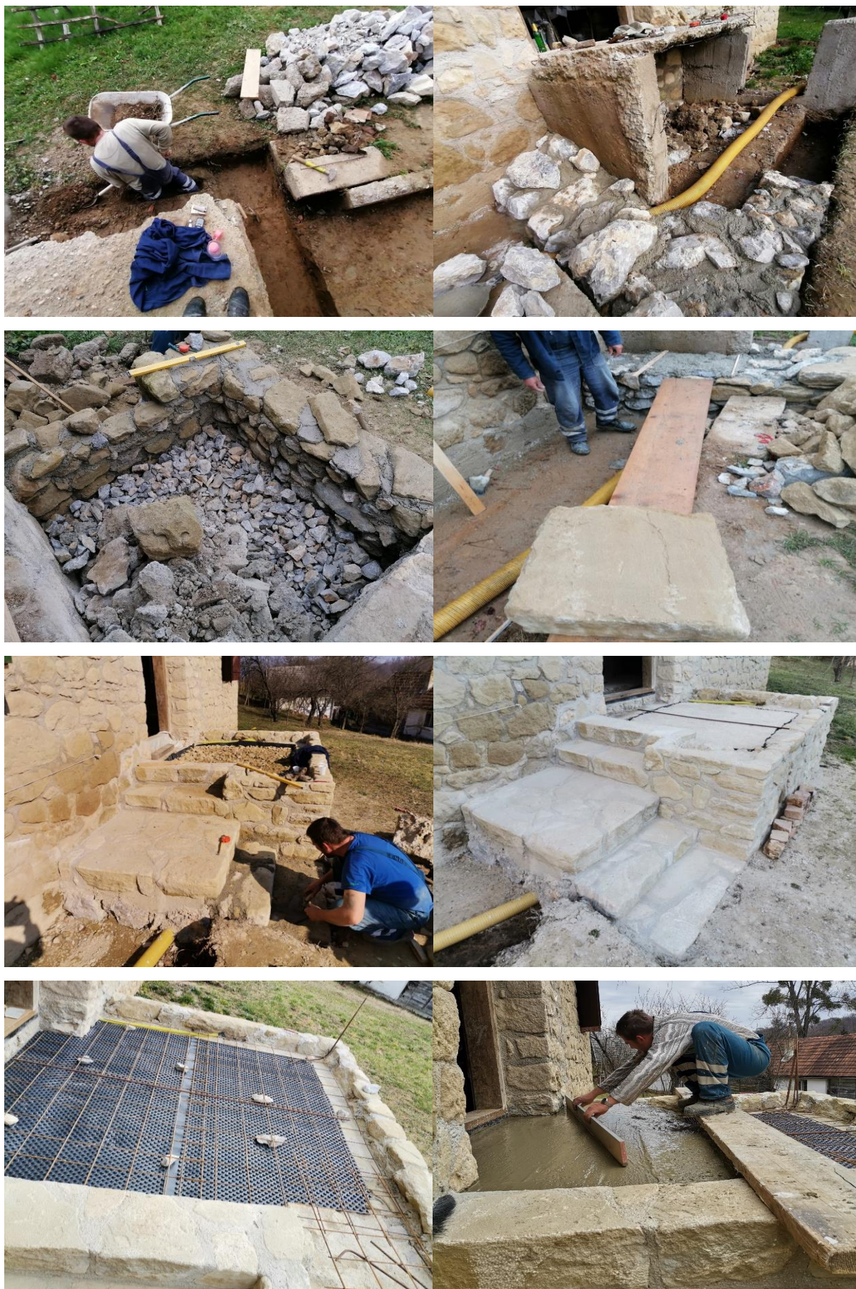
Slika 5.98: Postupak izrade terase
