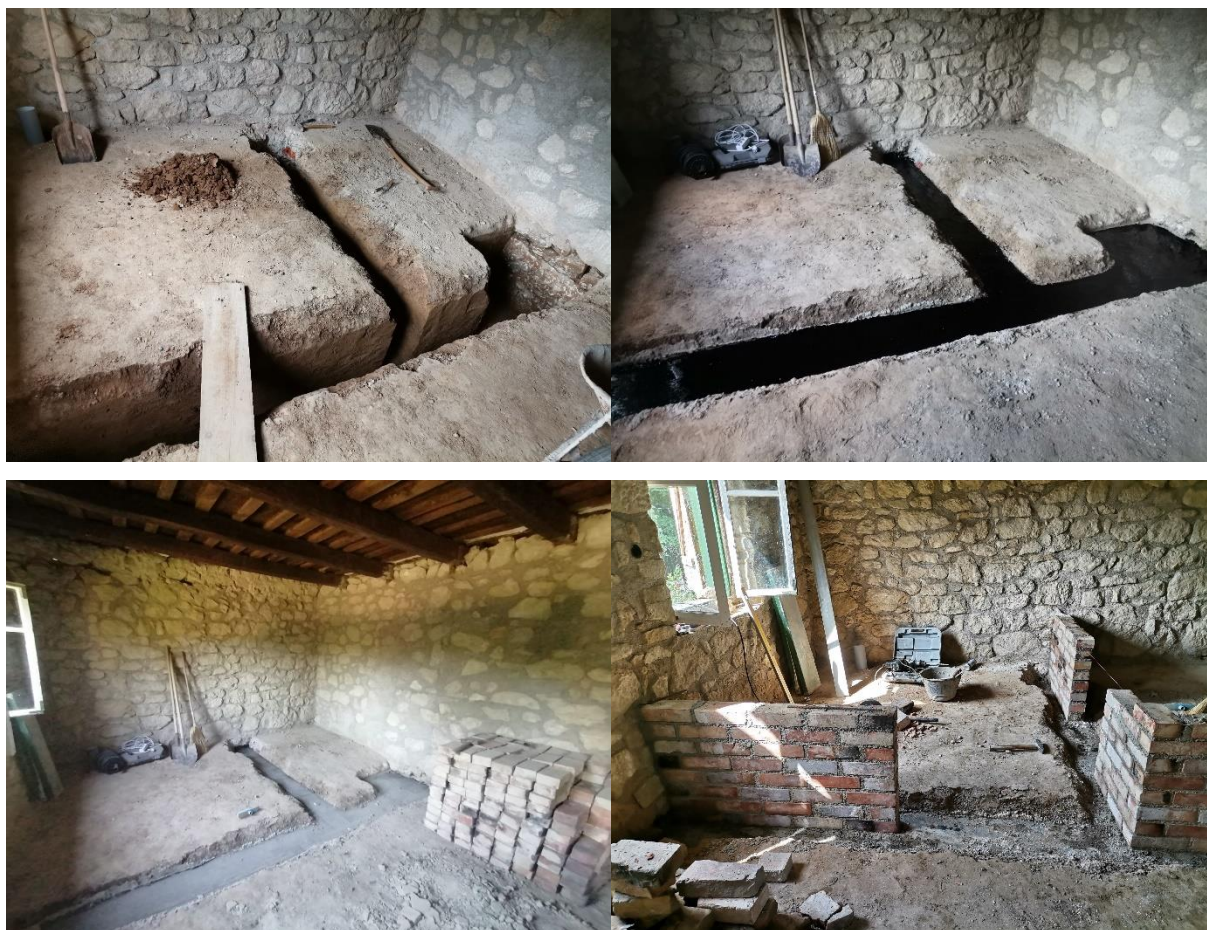
Slika 5.43: Iskop za temelje (gore lijevo), betoniranje temelja (gore desno), bitumenski premaz (dolje lijevo) i zidanje zida (dolje desno)
