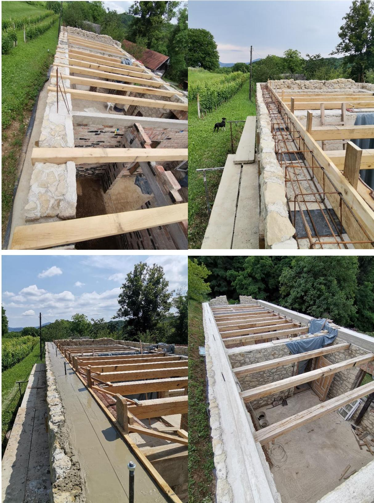
Slika 5.39: Ugradnja grednika u utore (gore lijevo), izrada kamenog zidića (gore desno), ugradnja ankera i betona (dolje lijevo), završni izgled serklaža (dolje desno)
