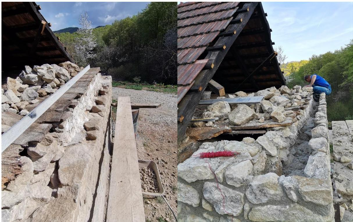
Slika 5.32: Uređivanje kamene kanalice (oplate) za budući serklaž
