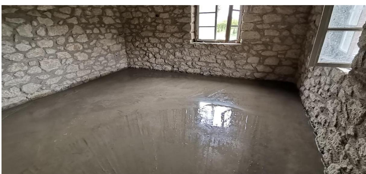
Slika 5.54: Razastiranje i zbijanje drenažnog sloja (gore), postavljanje PVC folije i armaturne (sredina) mreže, betoniranje ploče (dolje)
