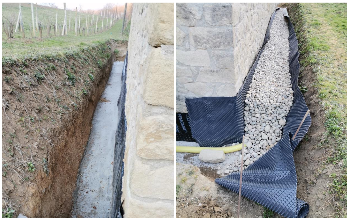
Slika 5.6: Izrada betonske podloge i drenaže oko objekta
