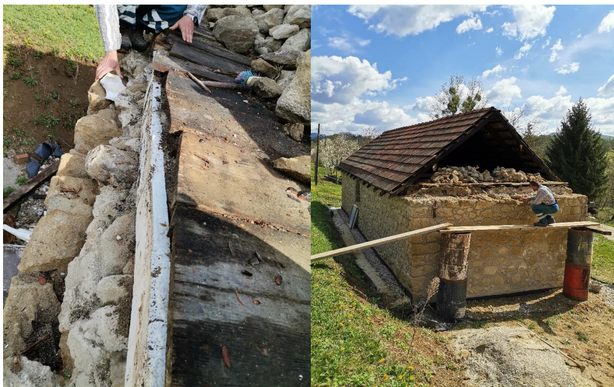
Slika 5.31: Uklanjanje grede u zabatnom zidu
