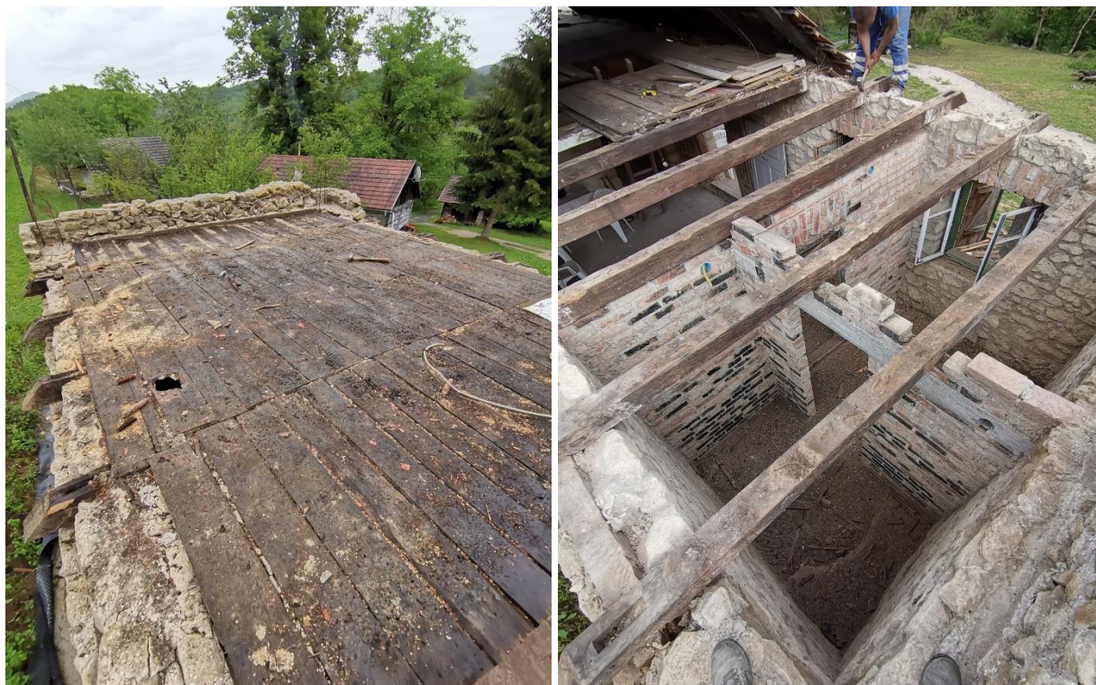
Slika 5.45: Izgled stropa i grednika prilikom demontaže
