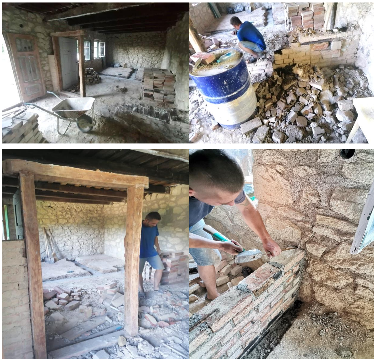
Slika 5.42: Rušenje pregradnog zida
