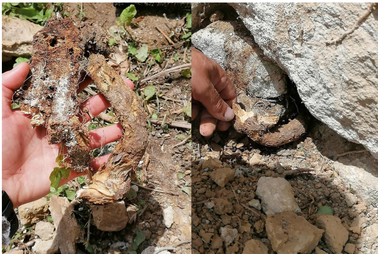
Slika 3.23: Prikaz korijenja prilikom iskopa s vanjske strane objekta
