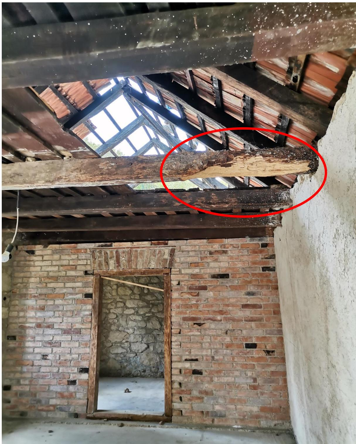
Slika 3.26: Prikaz istrunule grede nakon rušenja pregradnog zida ispod
