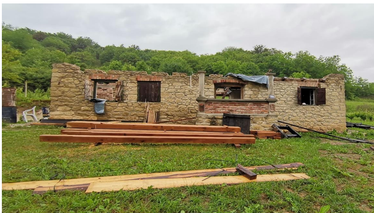
Slika 5.74: Objekt bez krova
