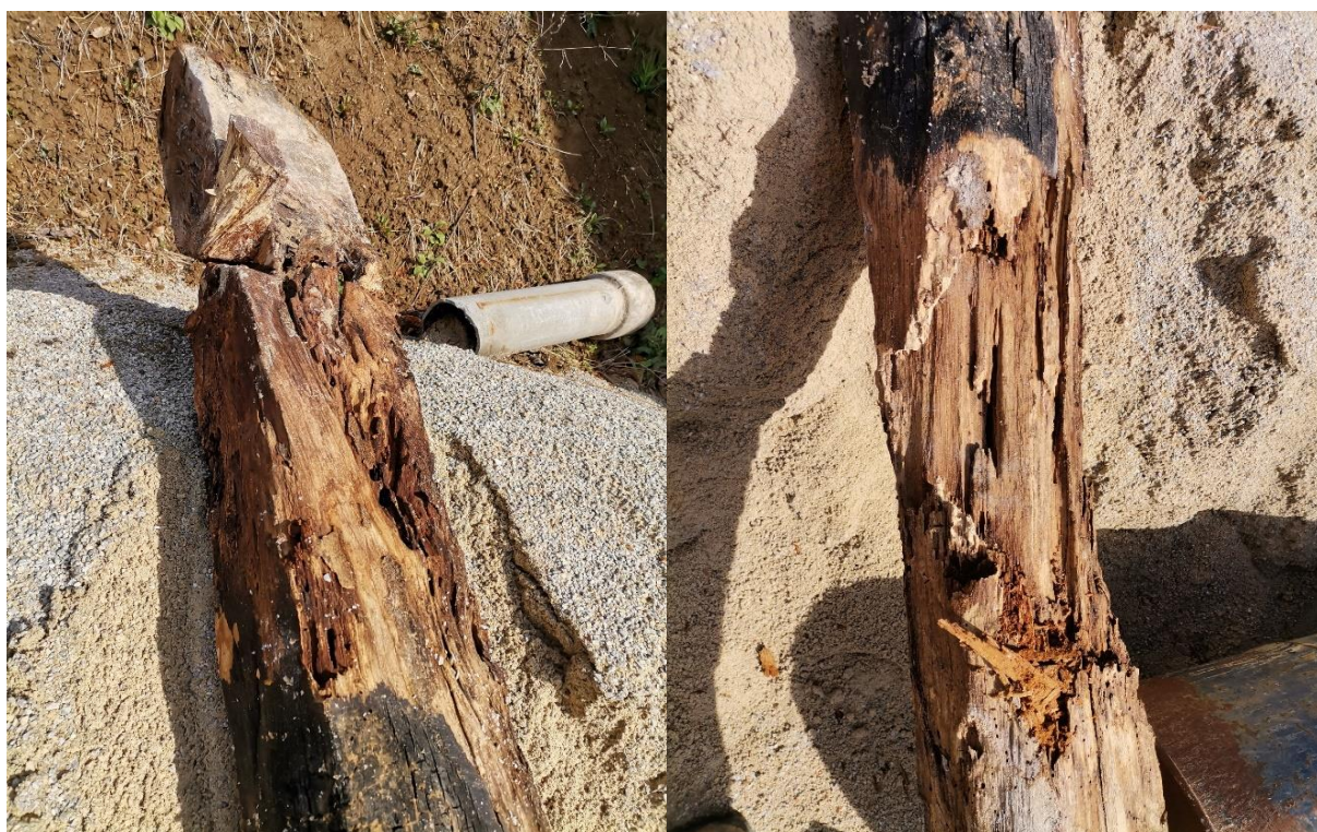
Slika 3.27: Prikaz istrunule građe nastale uslijed prokišnjanja
