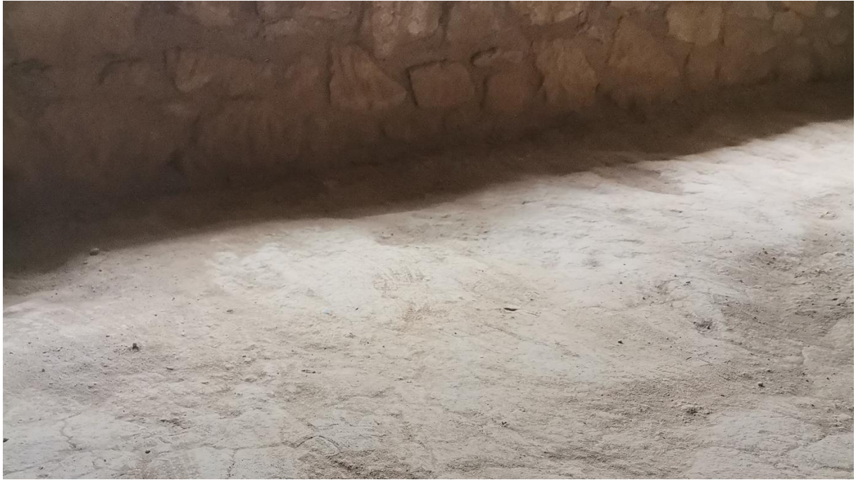
Slika 3.29: Zemljani pod unutar objekta
