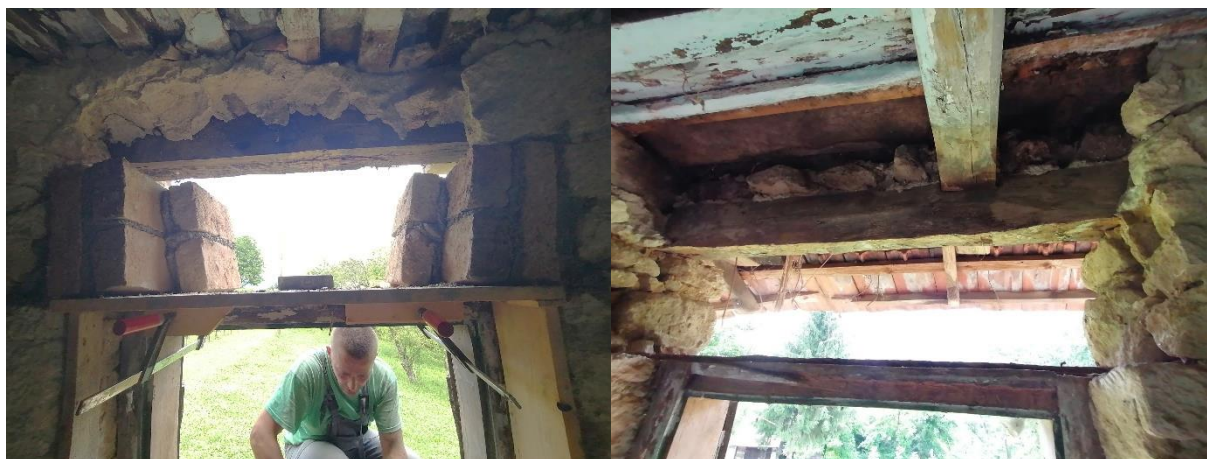
Slika 5.56: Nadvoji nakon rušenja
