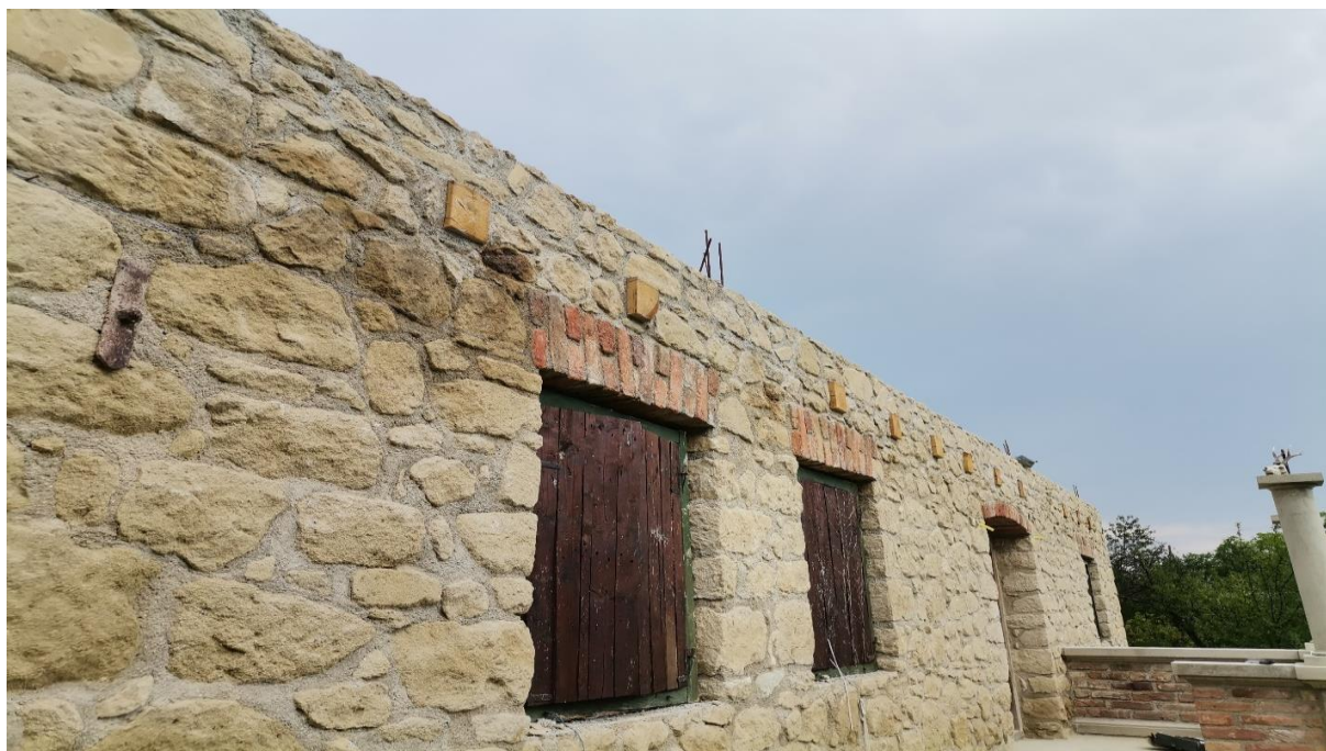
Slika 5.40: Izgled serklaža s pročelja
