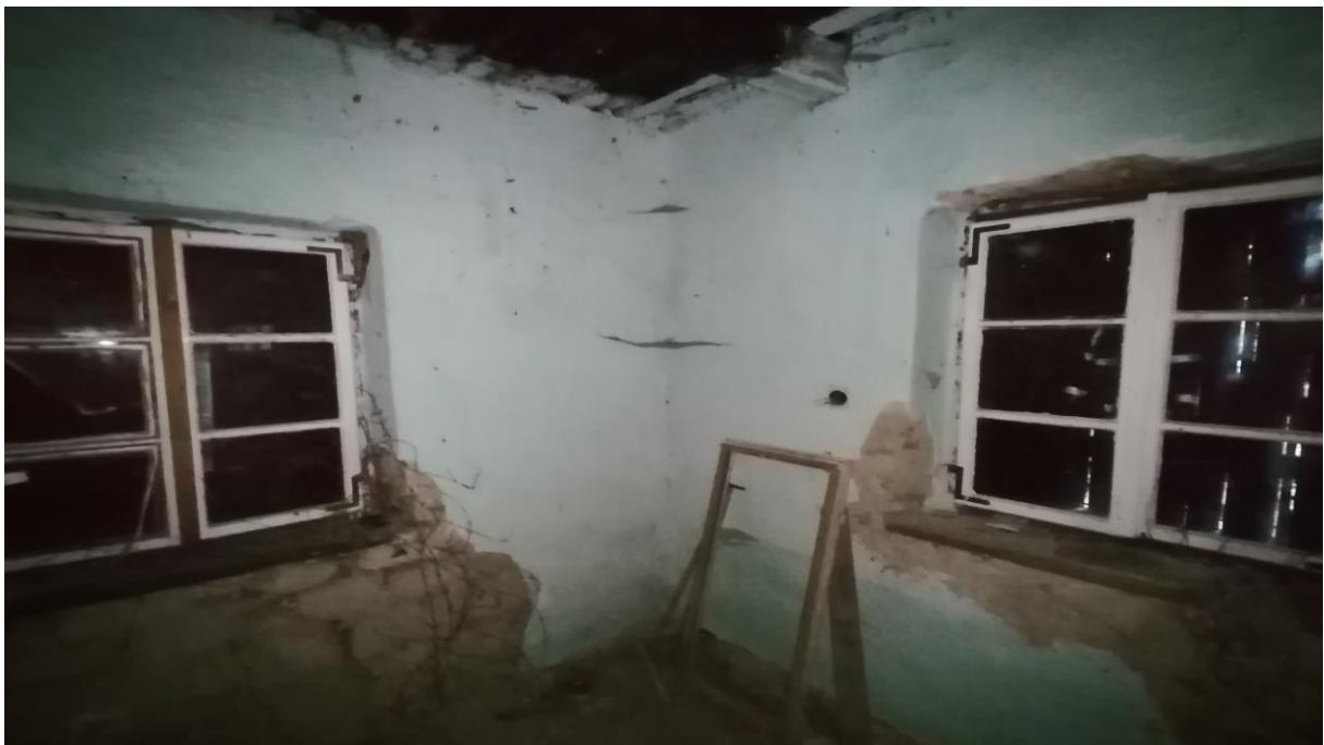
Slika 3.16: Stanje unutrašnjih zidova – prostorija 3
