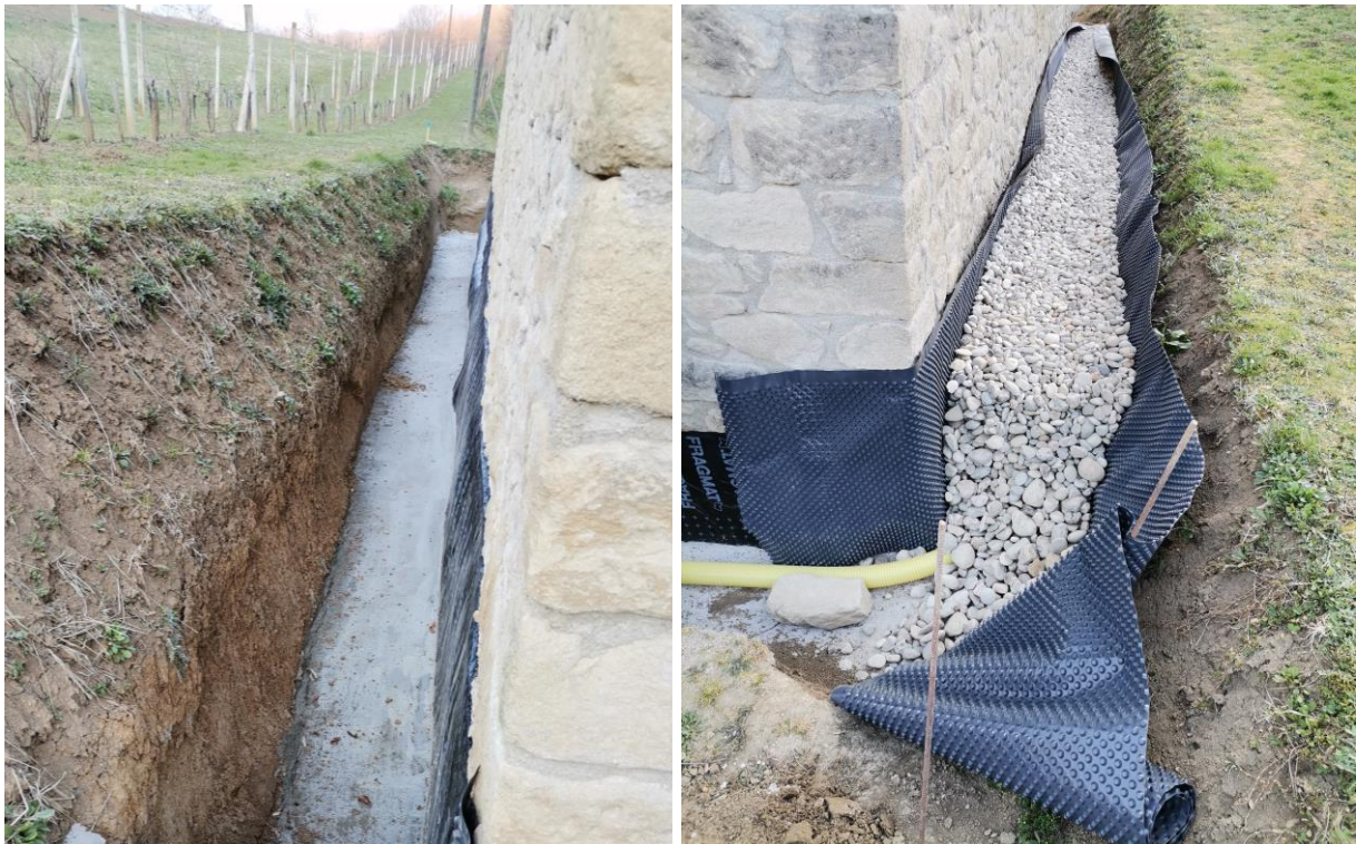
Slika 5.6: Izrada betonske podloge i drenaže oko objekta
