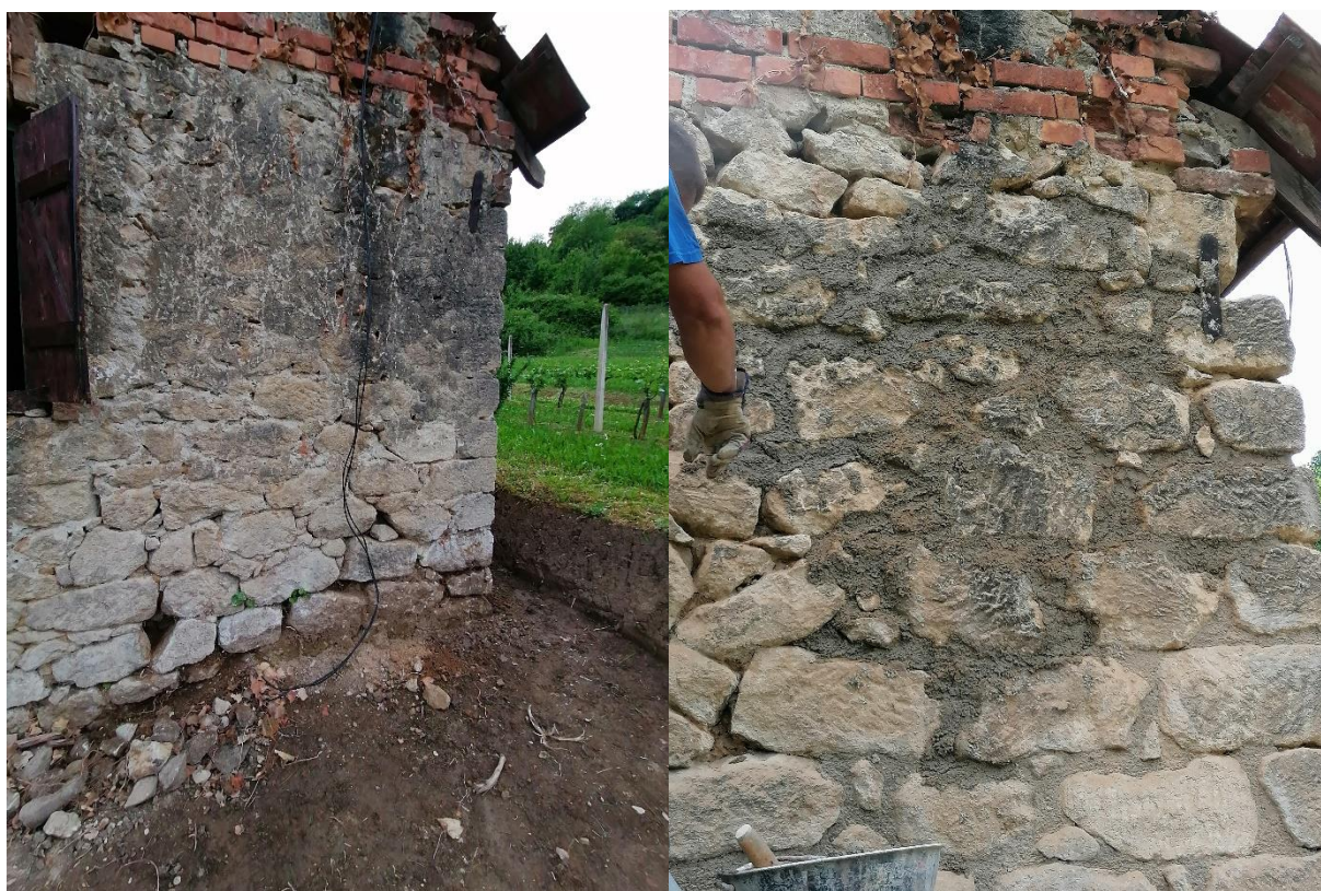
Slika 5.11: Stanje zidova prije i tijekom fugiranja
