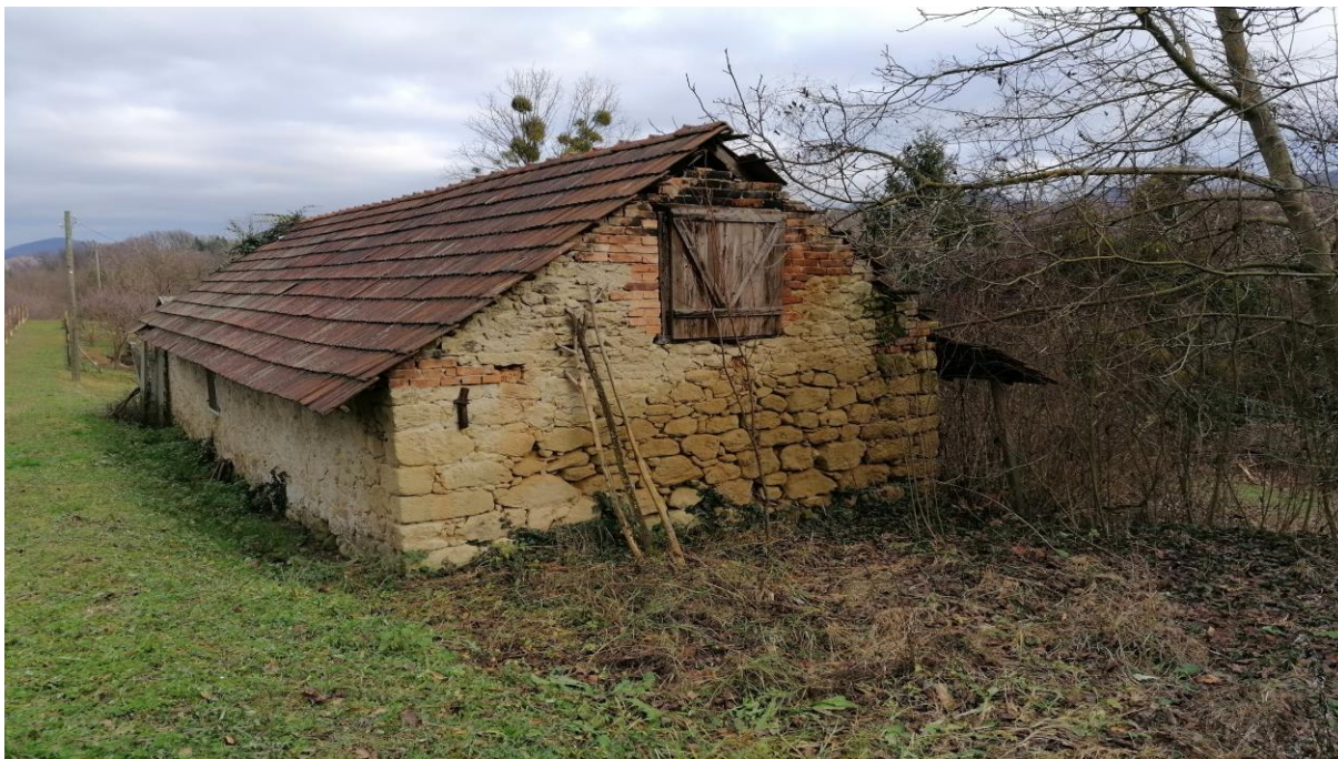
Slika 3.8: Zatečeno stanje – sjeverozapadno pročelje
