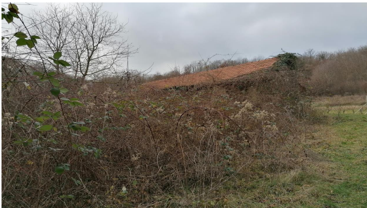
Slika 3.2: Zatečeno stanje – jugoistočno pročelje
