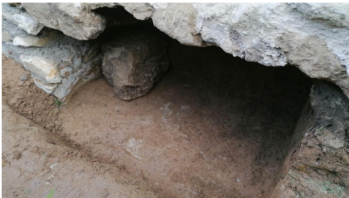
Slika 5.2: Potkopavanje temelja u etapama
