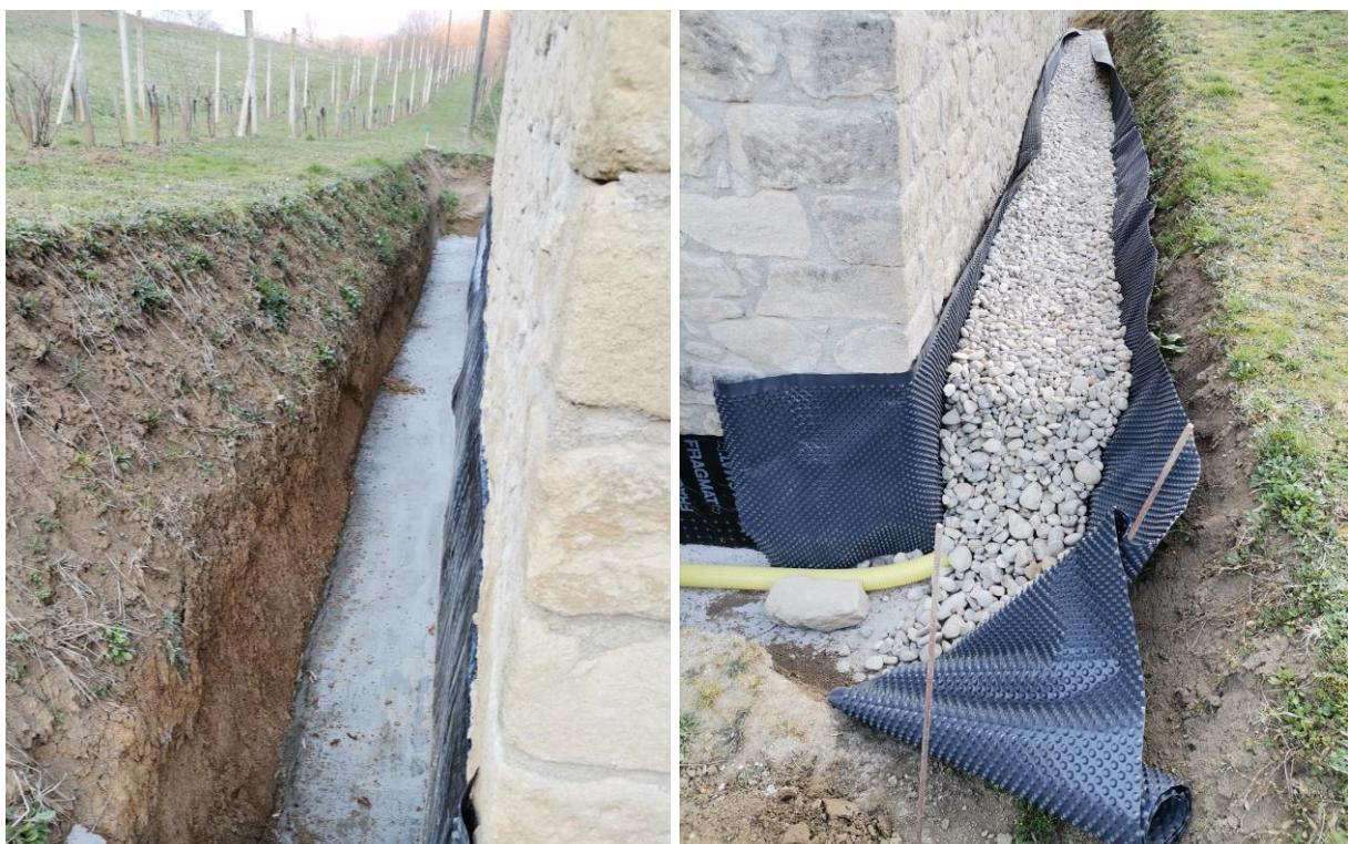
Slika 5.6: Izrada betonske podloge i drenaže oko objekta
