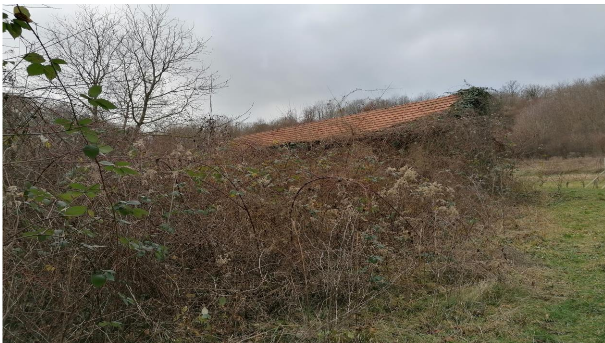
Slika 3.2: Zatečeno stanje – jugoistočno pročelje
