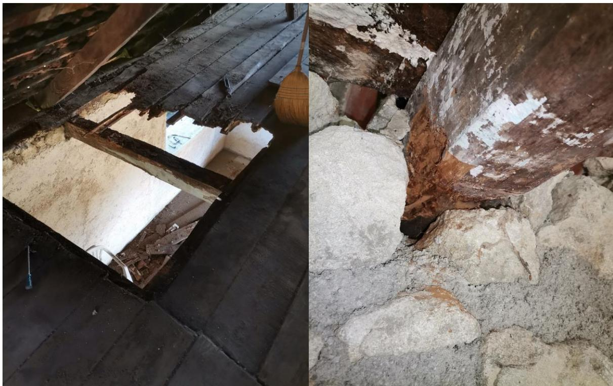
Slika 3.27: Prikaz istrunule građe nastale uslijed prokišnjavanja
