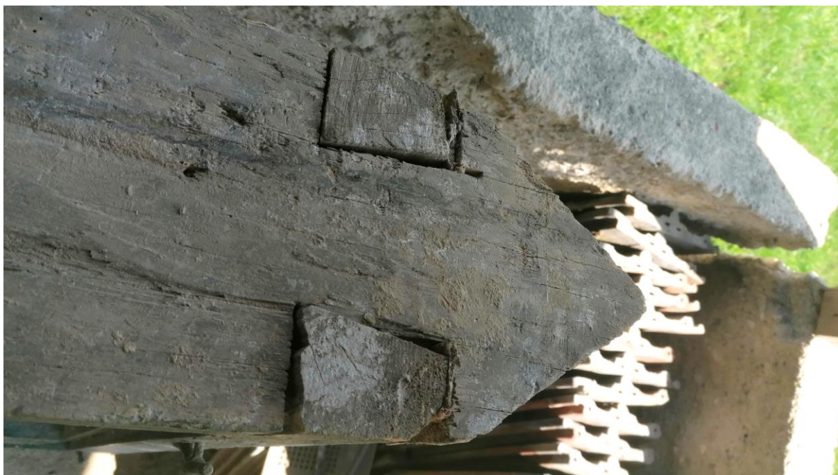
Slika 3.31: Način spajanja doprozornika
