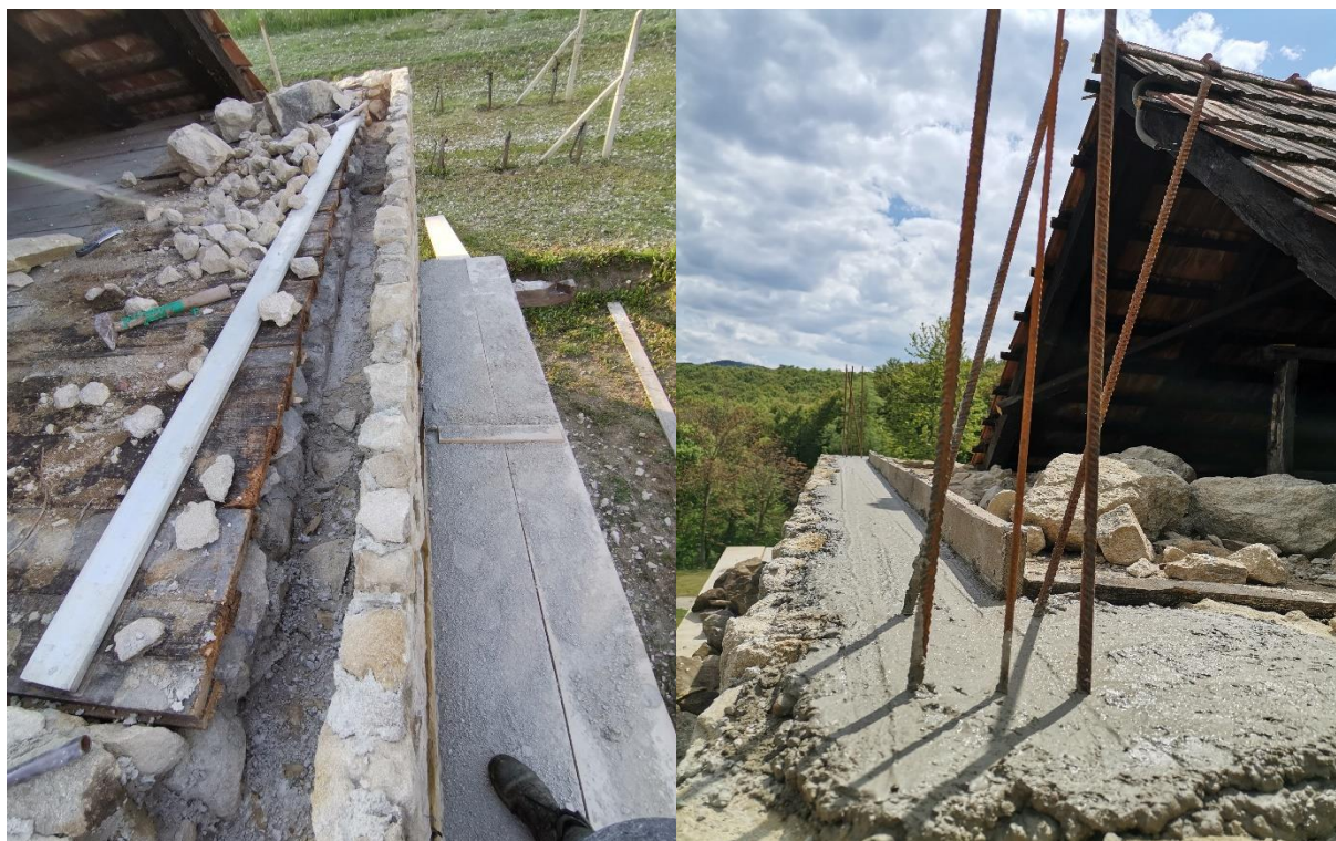
Slika 5.34: Ugradnja armature i betona u kamenu kanalicu (istočna strana)
