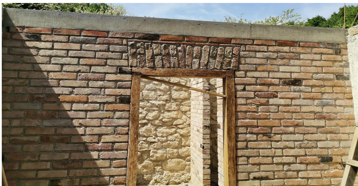
Slika 5.44: Gotovi pregradni zid
