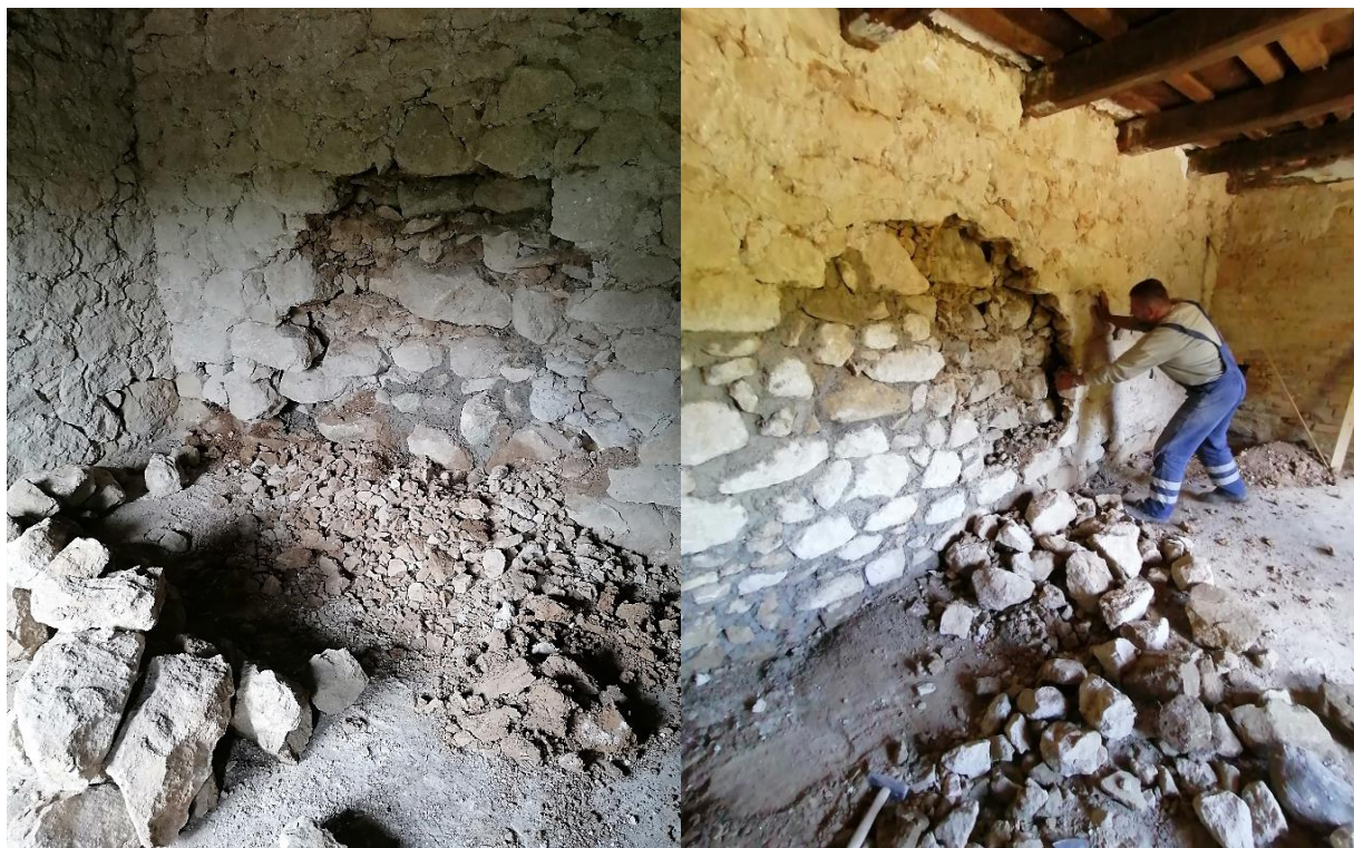
Slika 5.17: Rušenje i ponovno zidanje oštećenog zida
