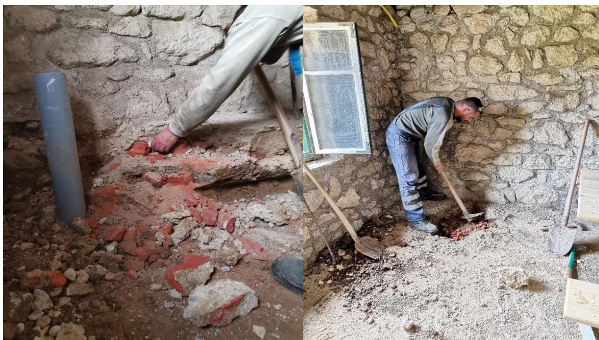
Slika 5.21: Uklanjanje mase od opeke i betona
