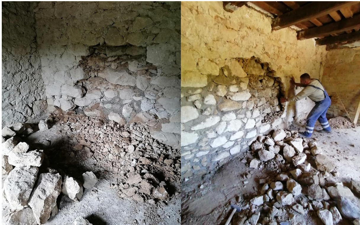
Slika 5.17: Rušenje i ponovno zidanje oštećenog zida
