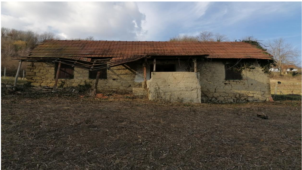
Slika 3.5: Zatečeno stanje – jugoistočno pročelje (bliži kadar) nakon čišćenja raslinja
