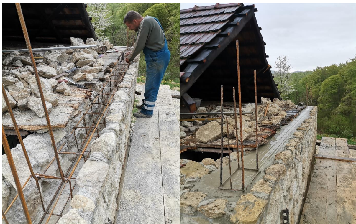
Slika 5.33: Ugradnja armature i betona u kamenu kanalicu (zapadna strana)
