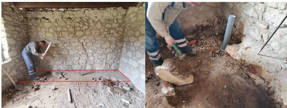
Slika 5.20: Razbijanje mase od opeke i betona
