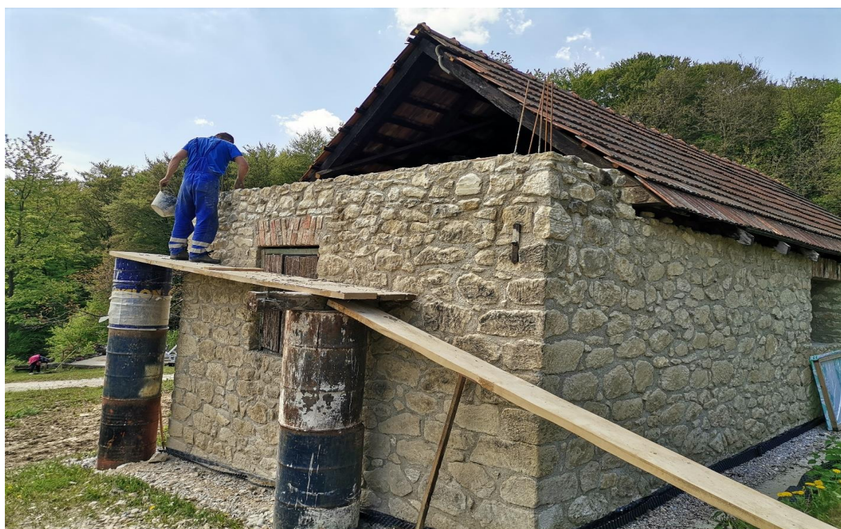
Slika 5.35: Ugradnja betona i improvizacija skele (istočna strana)
