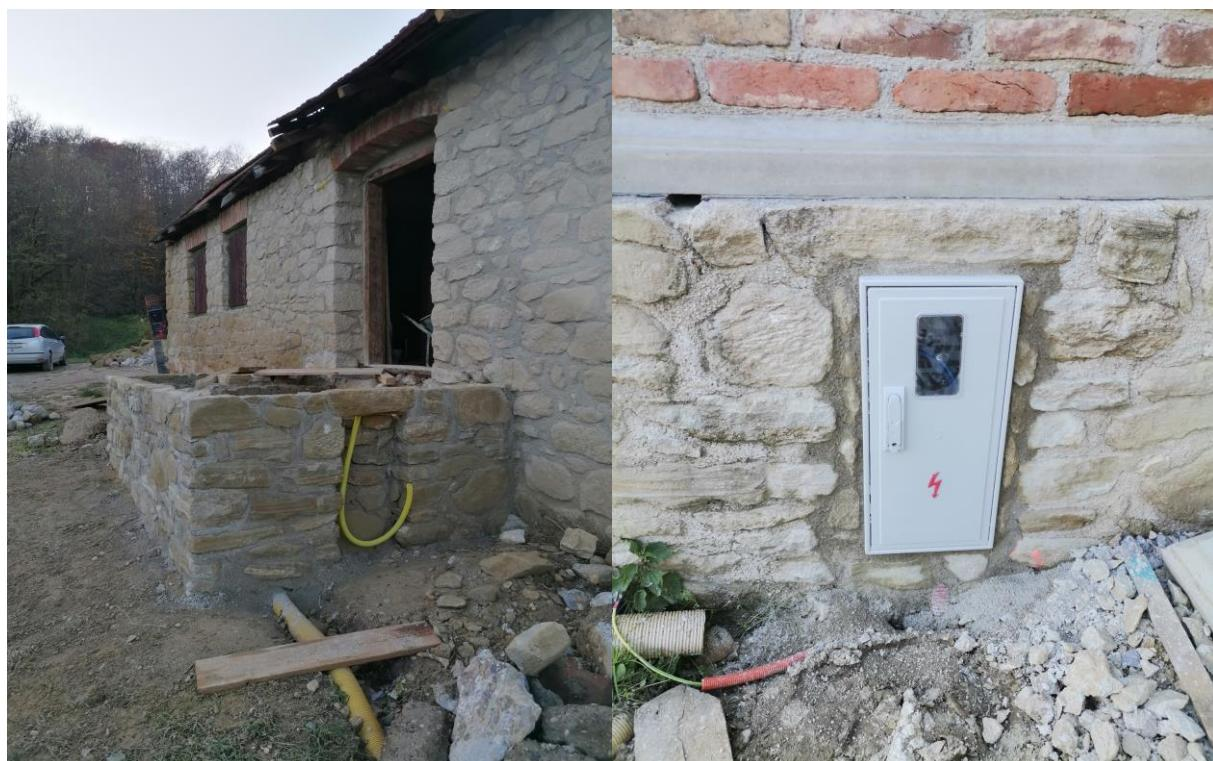
Slika 5.92: Ugradnja priključnog mjernog ormarića u nišu
