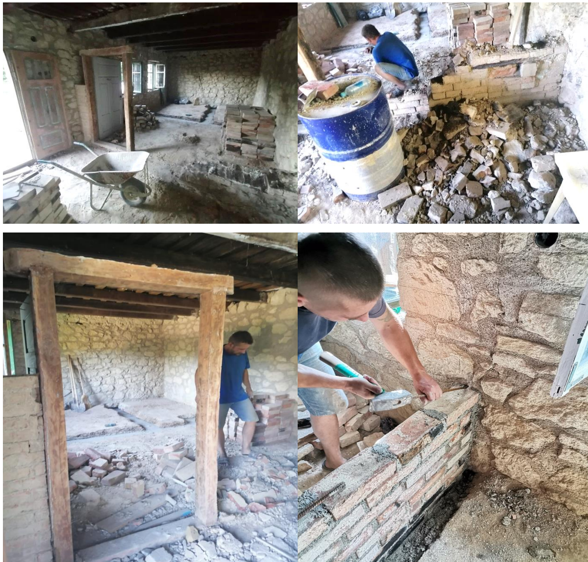
Slika 5.42: Rušenje pregradnog zida
