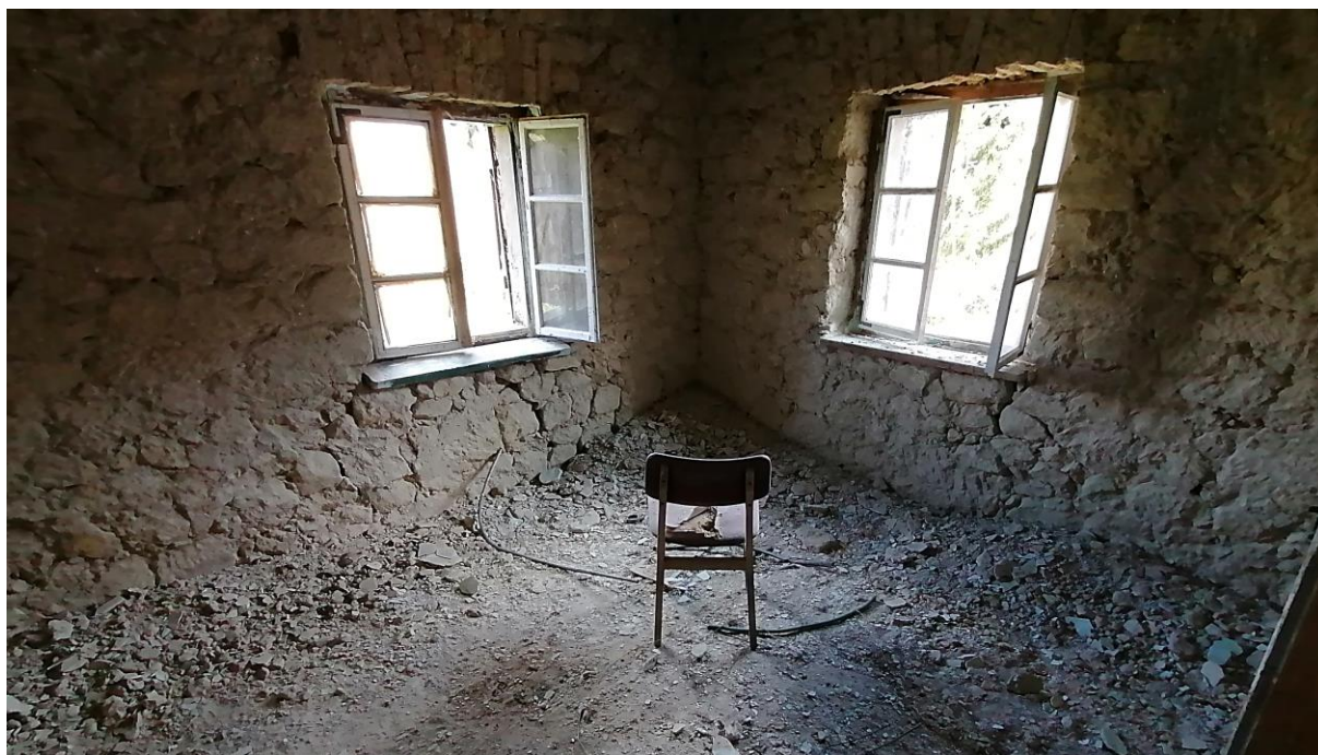
Slika 5.9: Izgled unutarnjih zidova nakon skidanja žbuke
