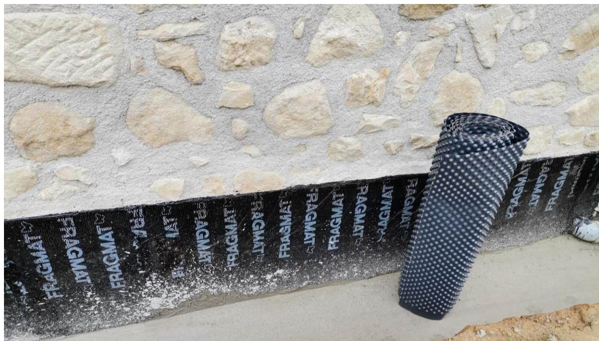
Slika 5.5: Bitumenska ljepenka, čepasta folija i betonska podloga
