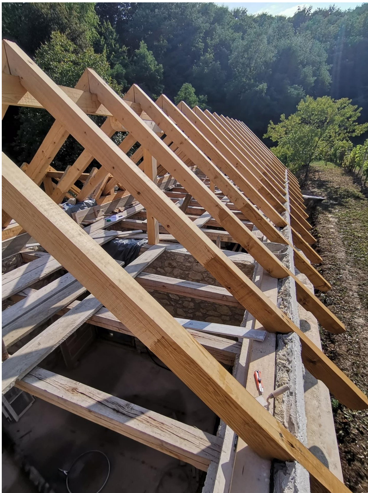
Slika 5.86: Kompozicija grednika, serklaža, nazidne grede, rogova i kamenog nadozida
