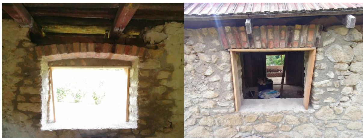
Slika 5.63: Izrada novog nadvoja
