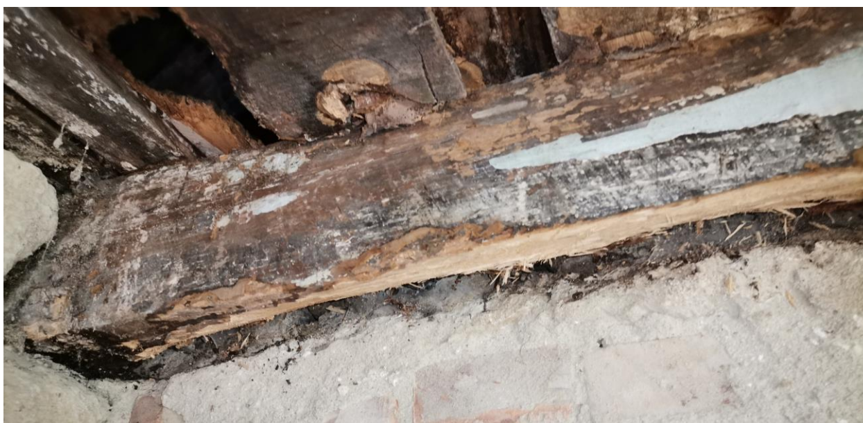
Slika 3.25: Propadanje drvene građe uslijed djelovanja vlage i prokišnavanja
