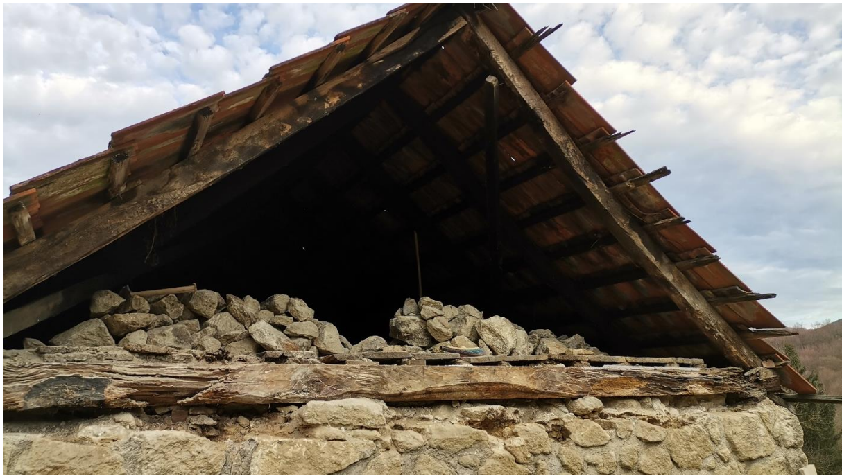
Slika 5.30: Rušenje zabatnog zida
