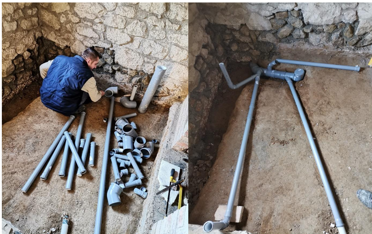
Slika 5.93: Postavljanje odvodnih i kanalizacionih cijevi
