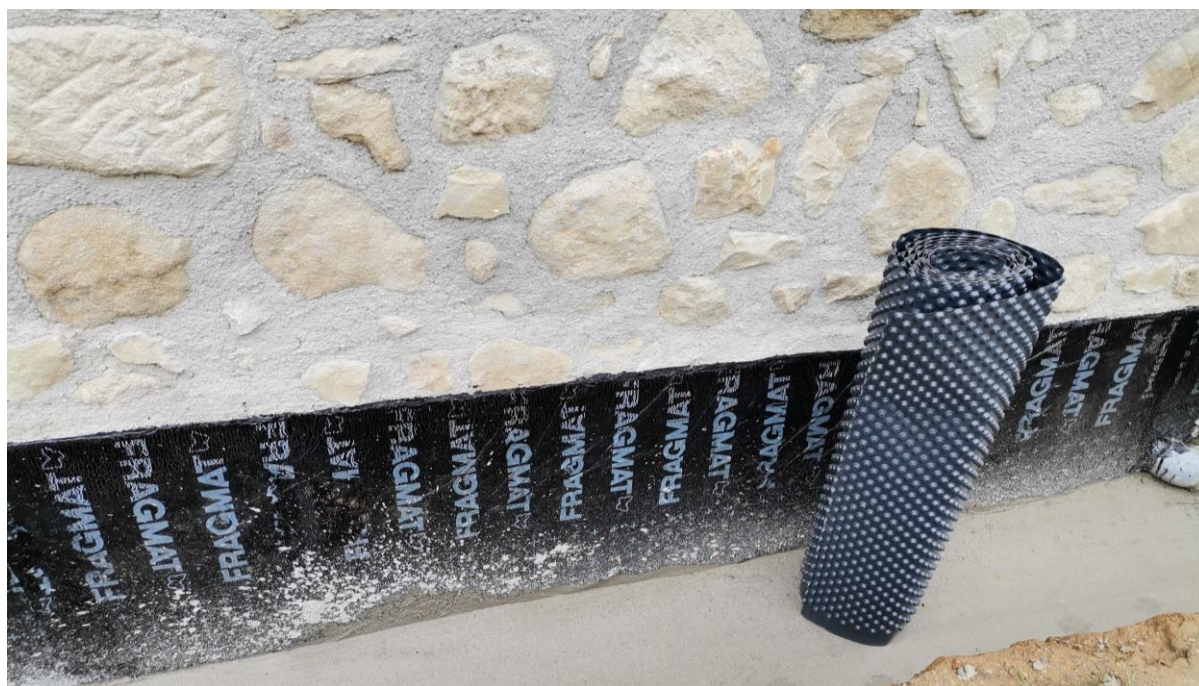
Slika 5.5: Bitumenska ljepjenka, čepasta folija i betonska podloga
