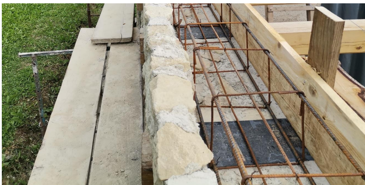
Slika 5.49: Bitumenska ljepenka ispod i iznad grednika
