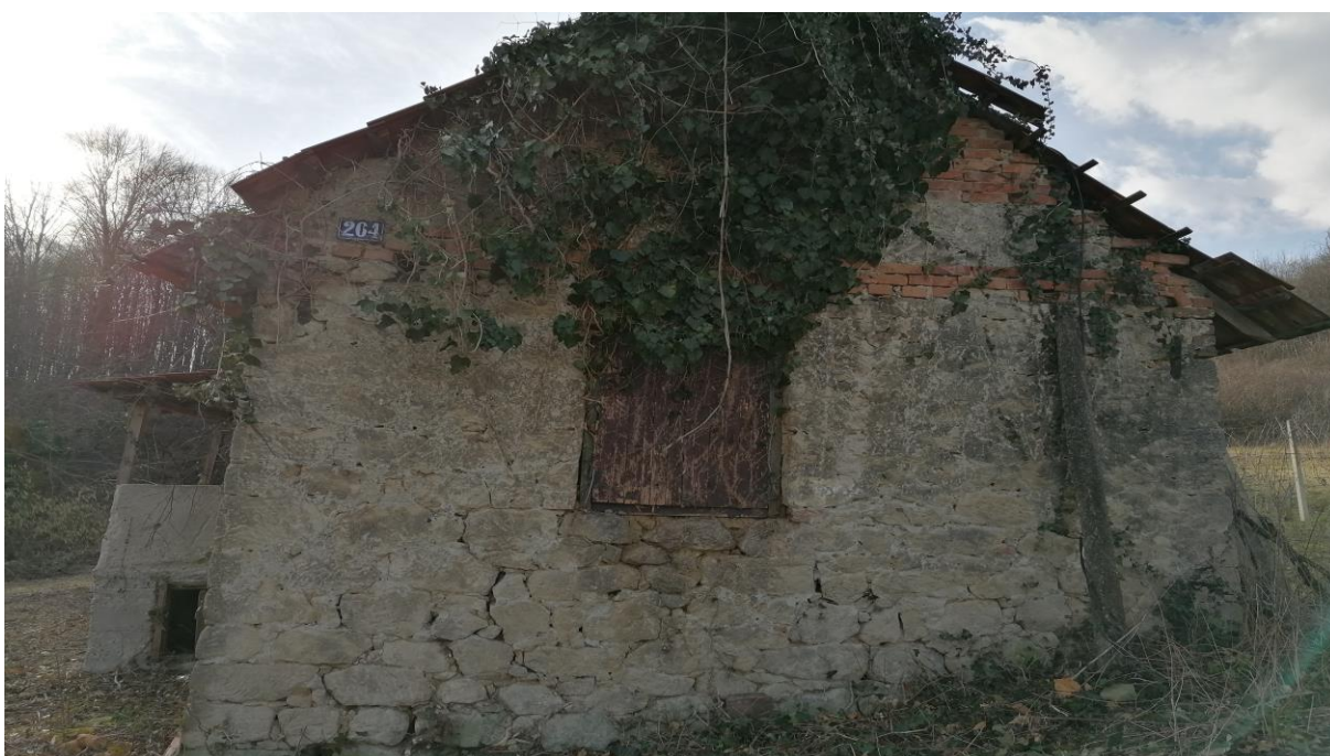
Slika 3.7: Zatečeno stanje – sjeveroistočno pročelje nakon čišćenja raslinja
