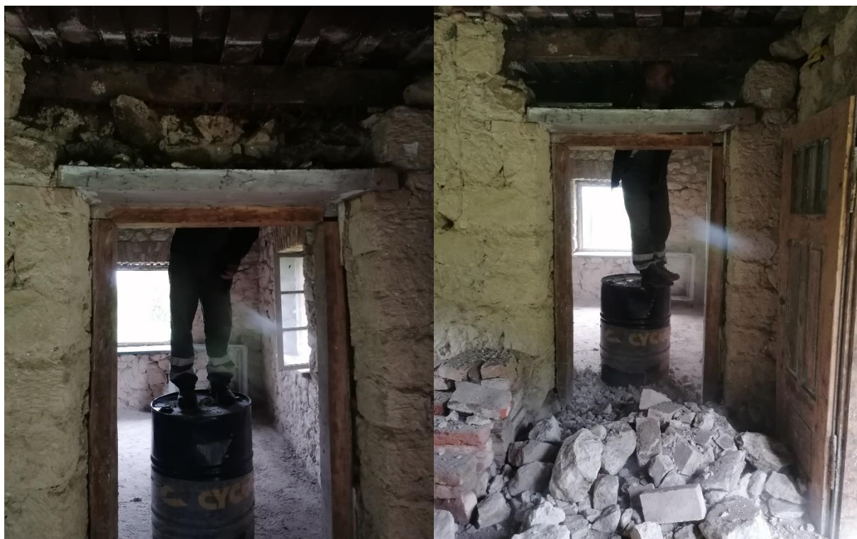
Slika 5.65: Rušenje nadvoja iznad sobnih vrata
