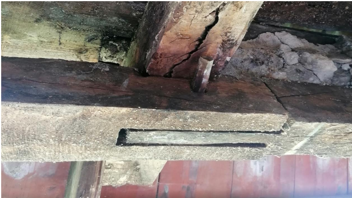
Slika 3.35: Način spajanja nazidnih greda
