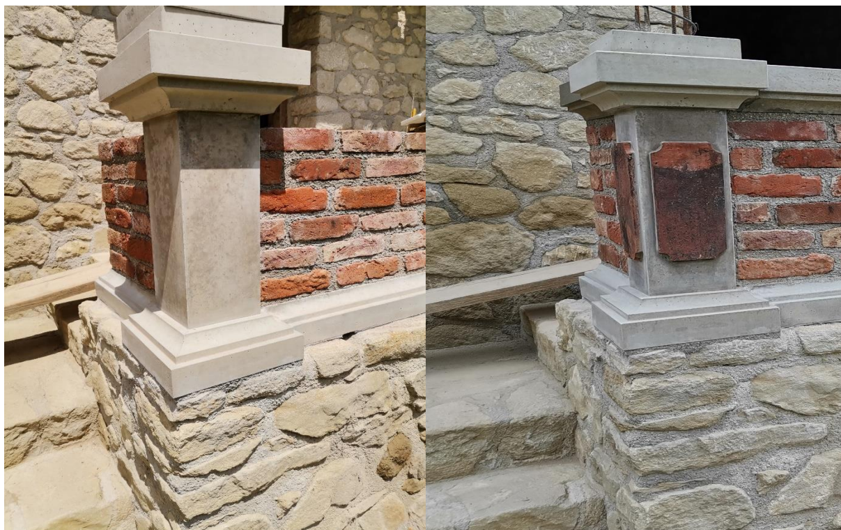
Slika 5.101: Izgled stupa terase prije i poslije dodavanja dekorativnog elementa
