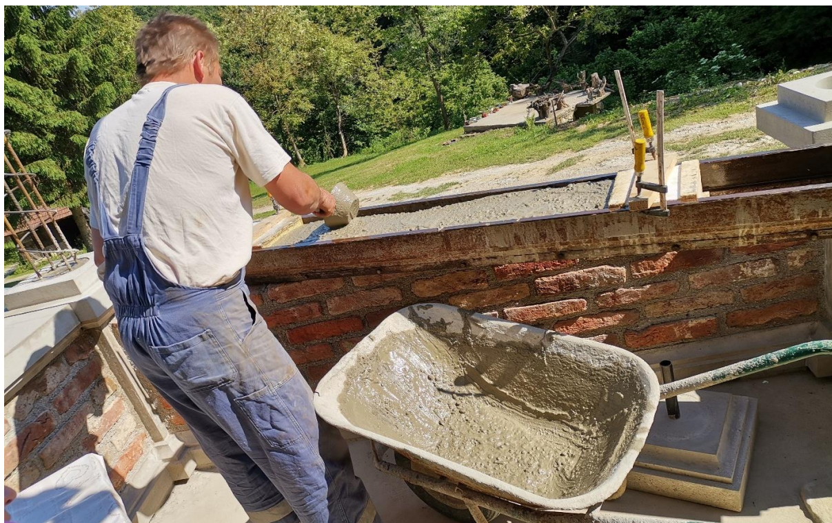
Slika 5.99: Betoniranje rukohvata ograde
