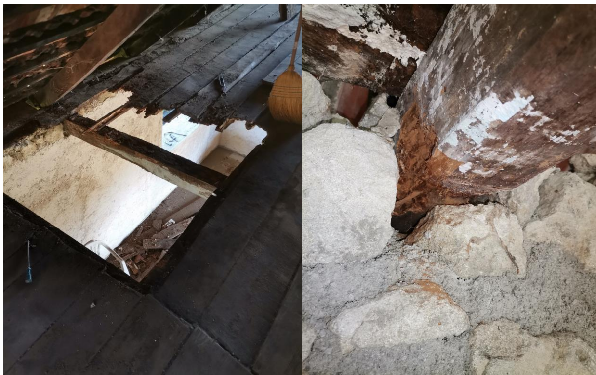
Slika 3.27: Prikaz istrunule građe nastale uslijed prokišnjanja
