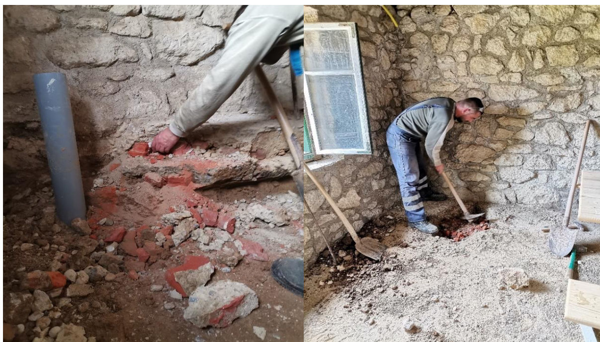
Slika 5.21: Uklanjanje mase od opeke i betona
