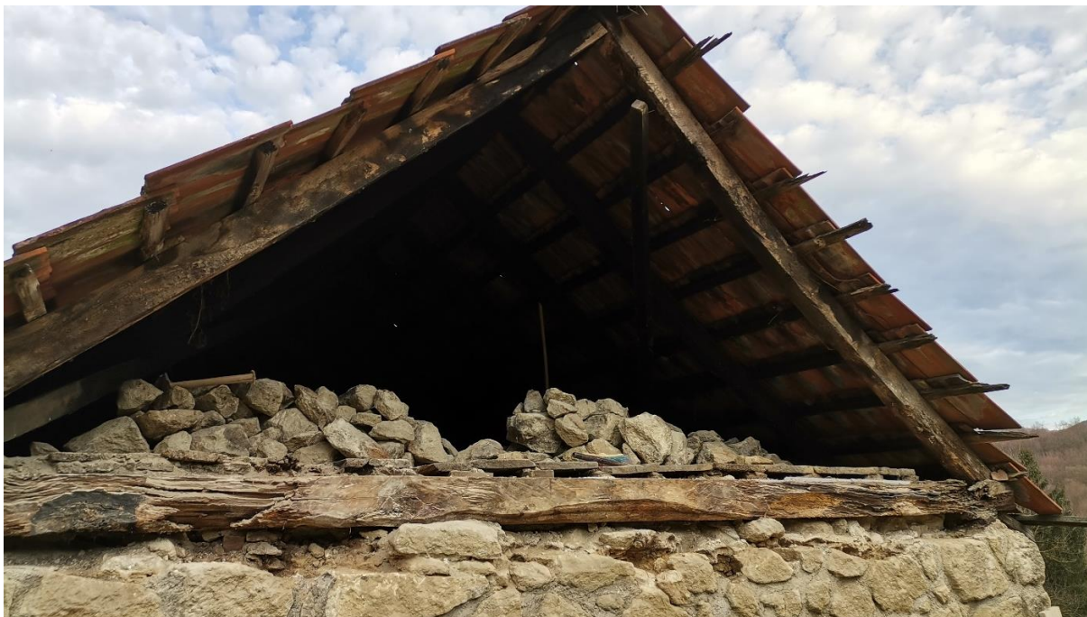
Slika 5.30: Rušenje zabatnog zida
