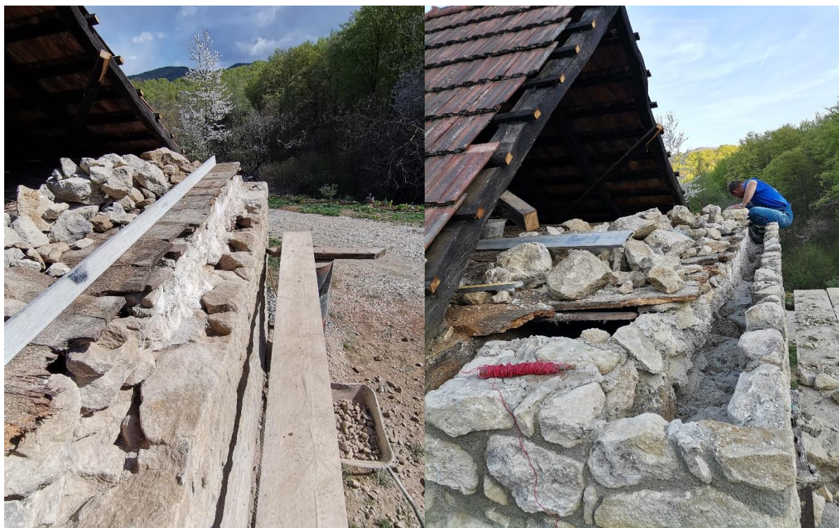
Slika 5.32: Uređivanje kamene kanalice (oplate) za budući serklaž
