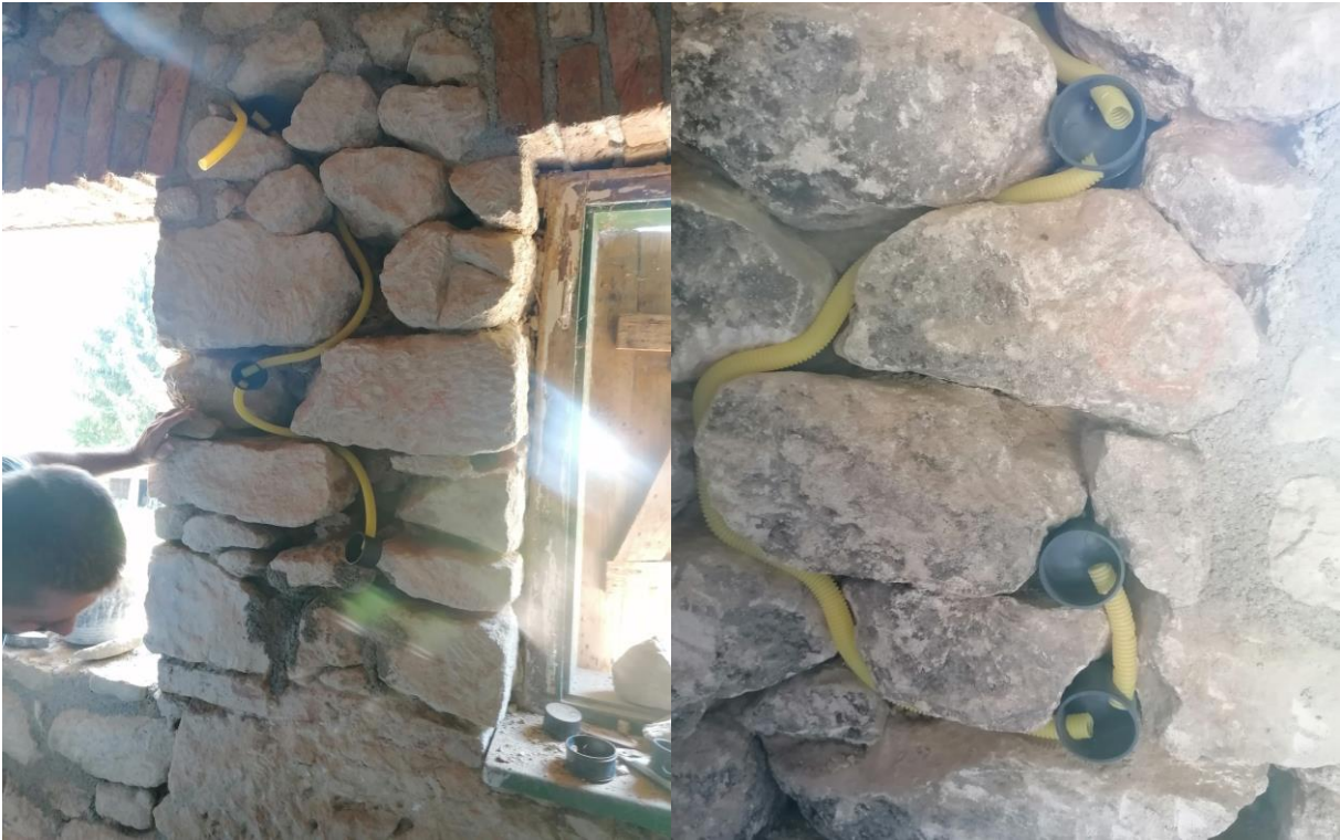
Slika 5.91: Postavljanje božira za struju
