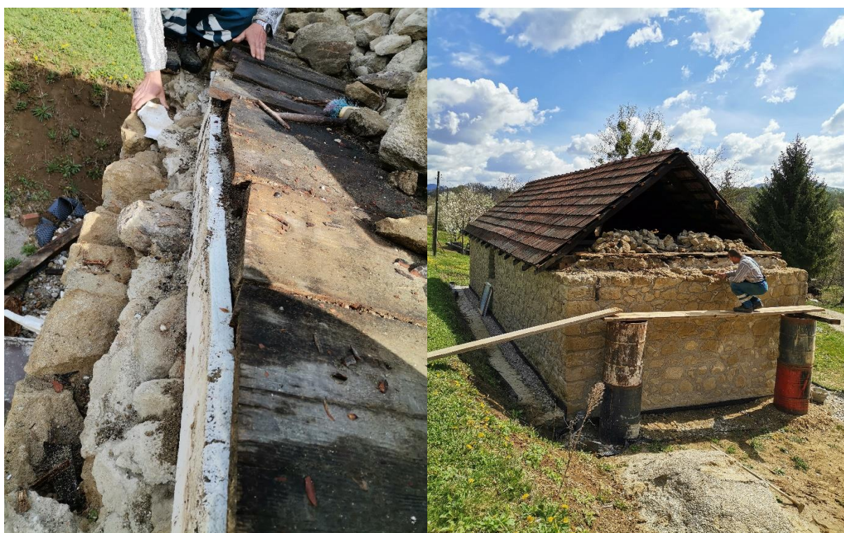
Slika 5.31: Uklanjanje grede u zabatnom zidu
