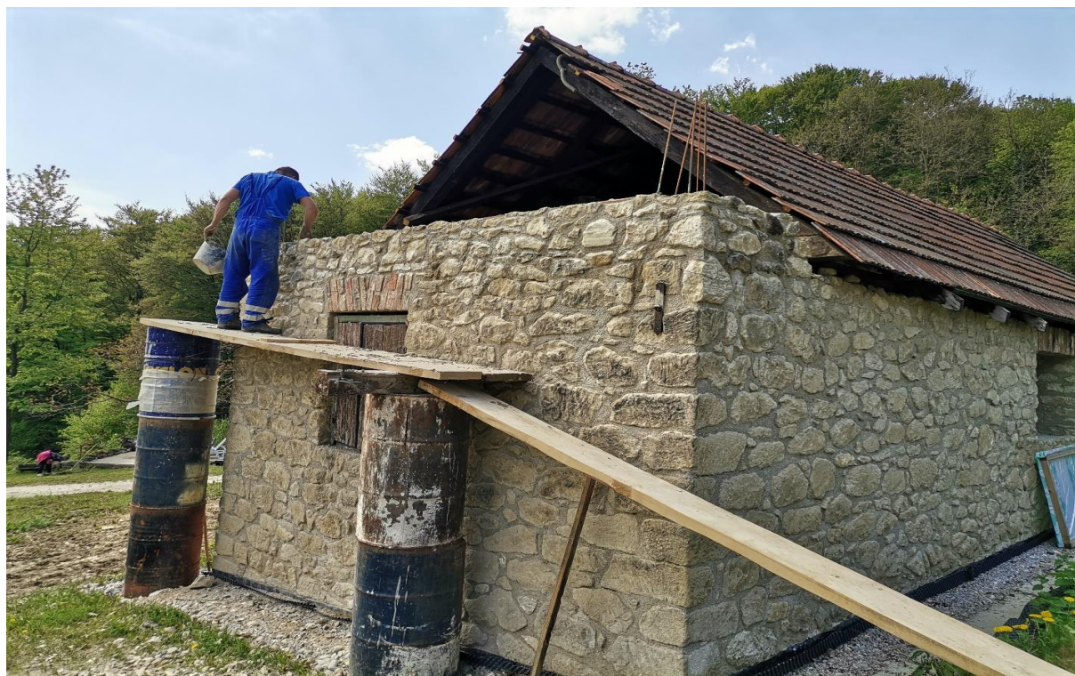
Slika 5.35: Ugradnja betona i improvizacija skele (istočna strana)
