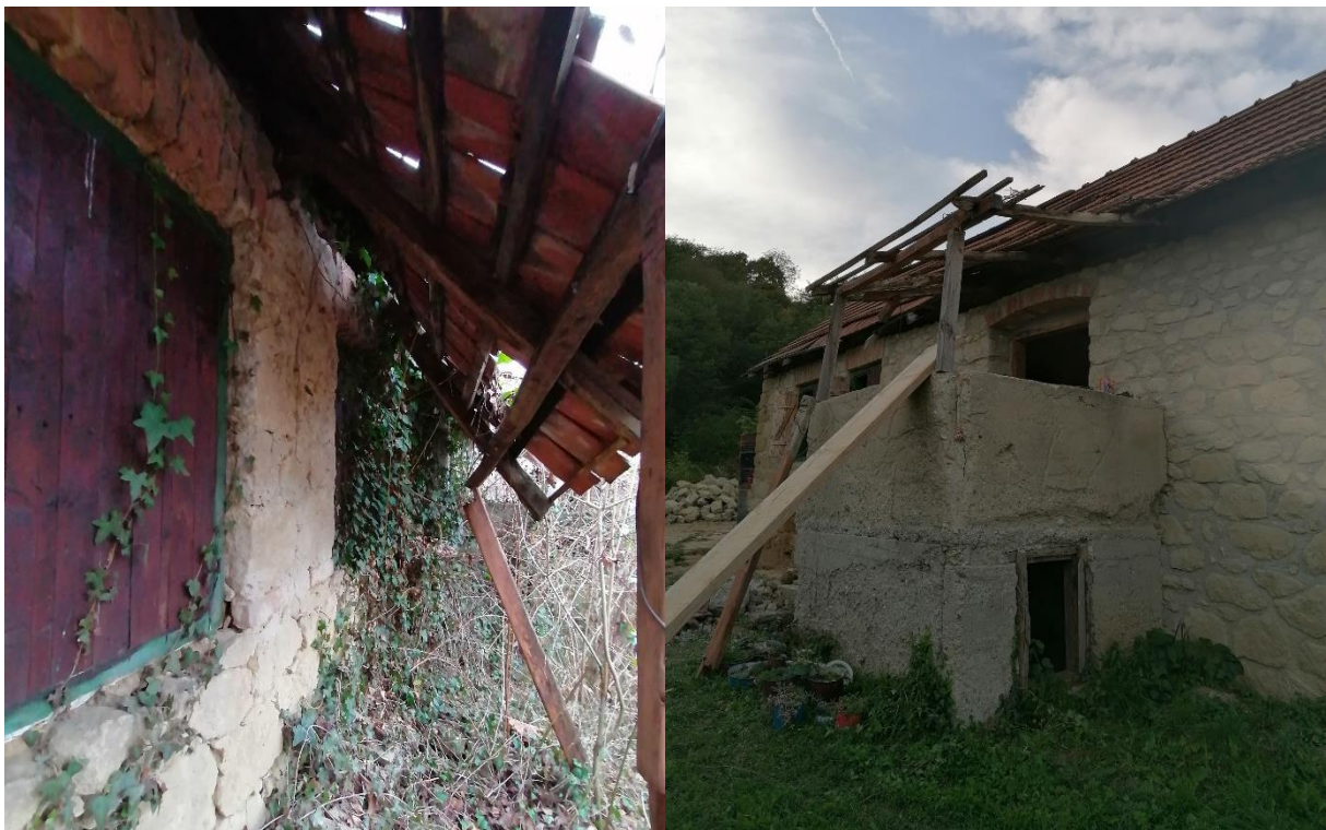
Slika 5.96: Izgled postojeće terase na objektu
