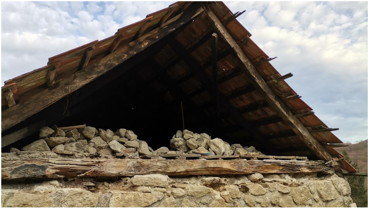
Slika 5.30: Rušenje zabatnog zida
