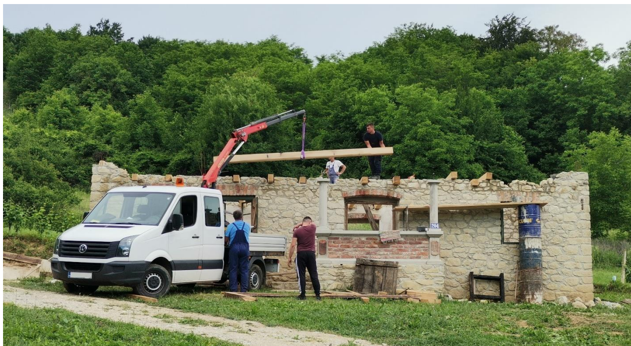
Slika 5.48: Ugradnja novih grednika
