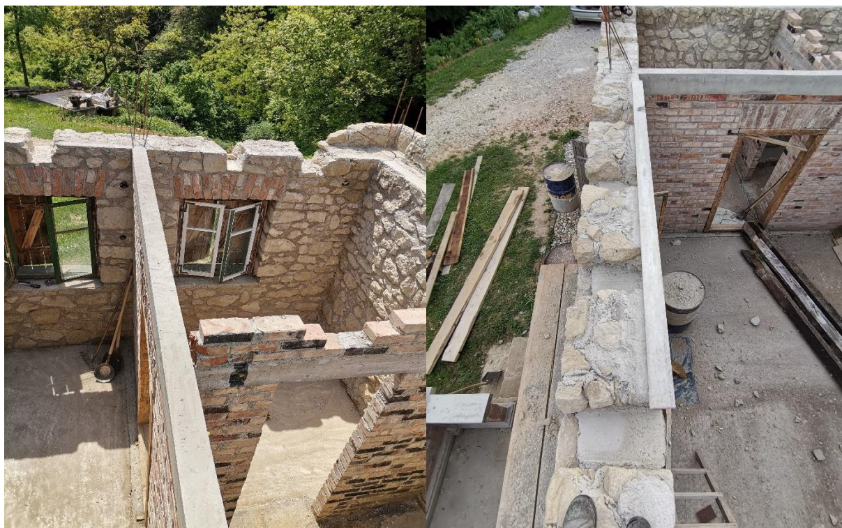
Slika 5.37: Izrada serklaža (pregradni zid) i utori za grednike
