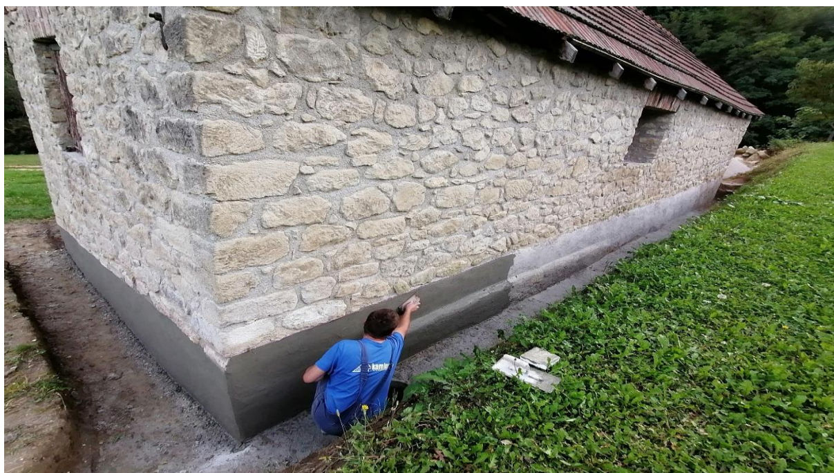
Slika 5.4: Izgled temelja prije i poslije
