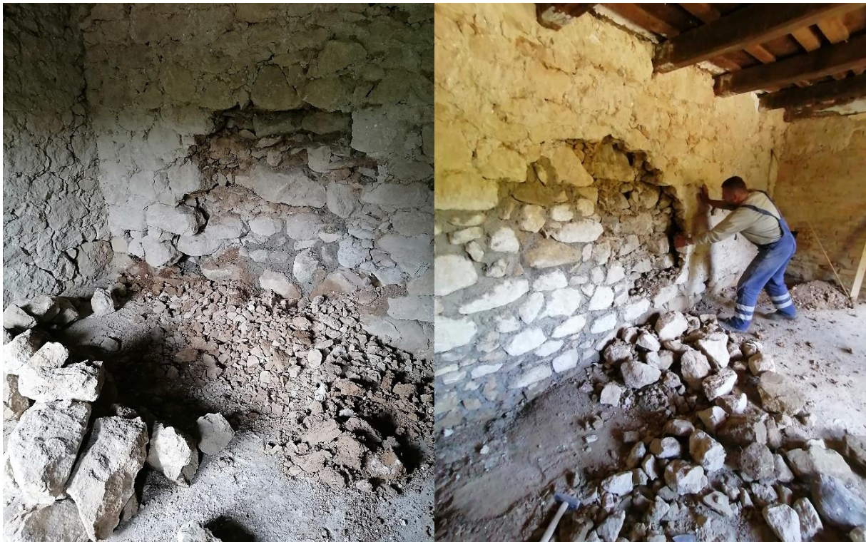
Slika 5.17: Rušenje i ponovno zidanje oštećenog zida
