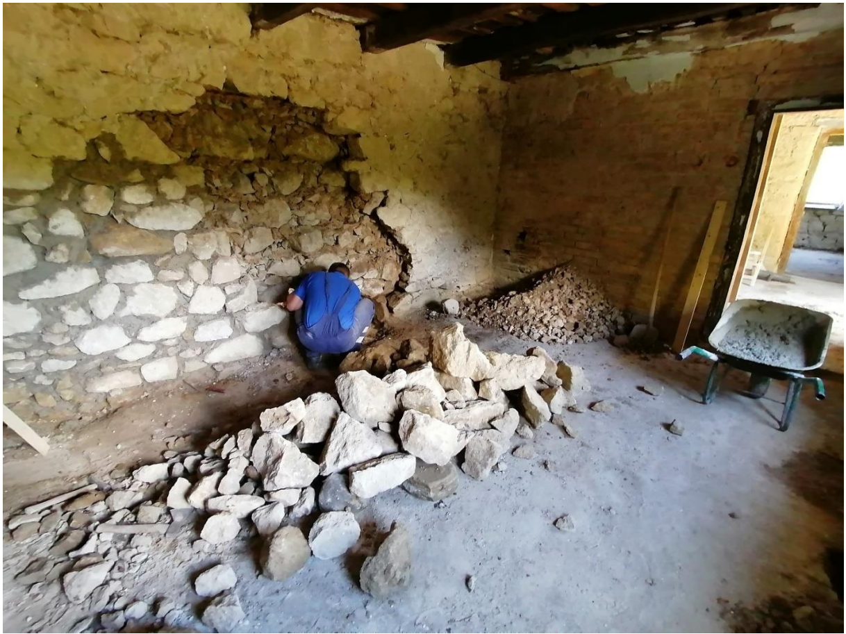
Slika 5.16: Rušenje zida i ponovno zidanje zida
