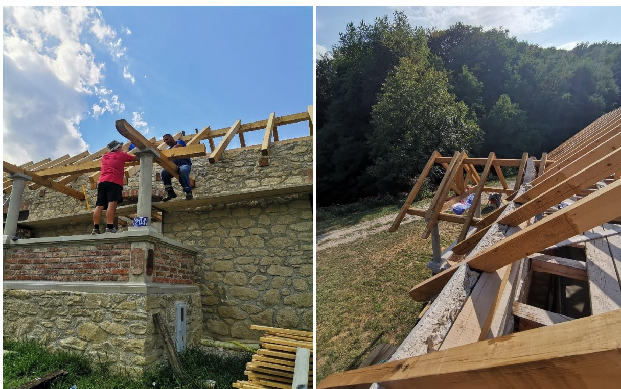
Slika 5.85: Izrada krova terase
