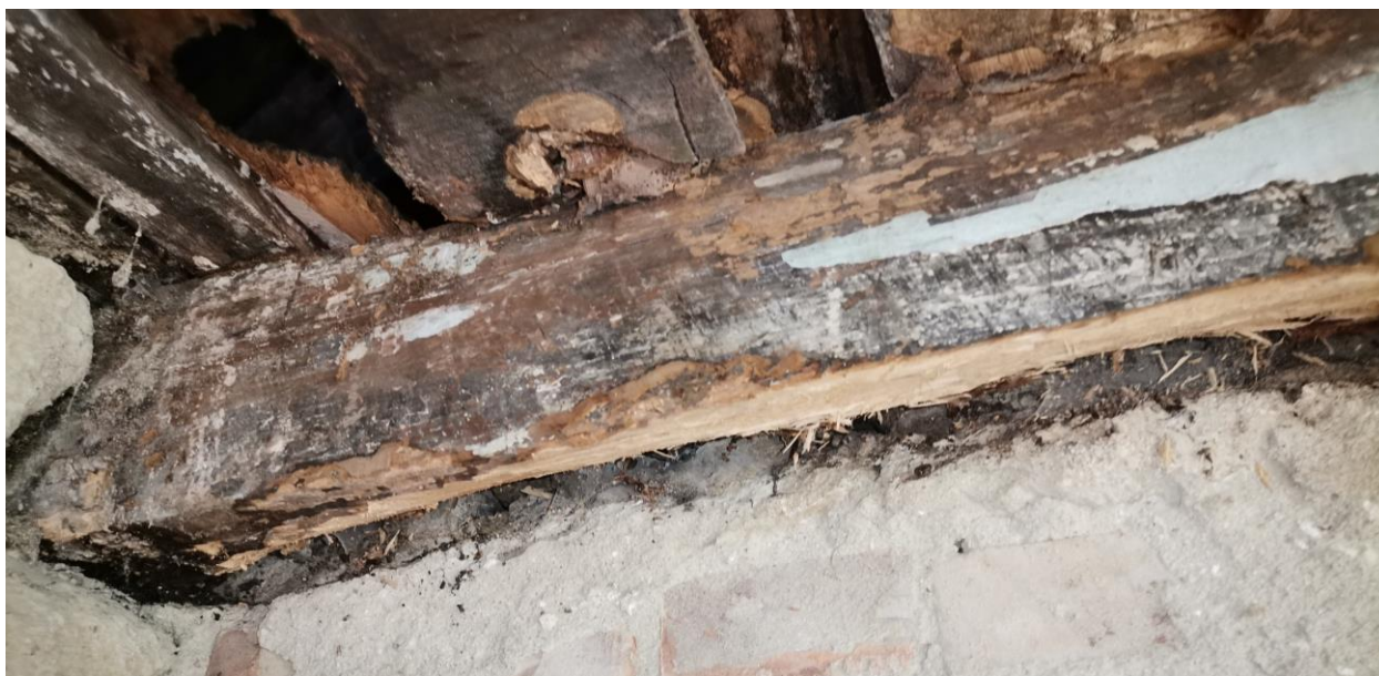
Slika 3.25: Propadanje drvene građe uslijed djelovanja vlage i prokišavanja
