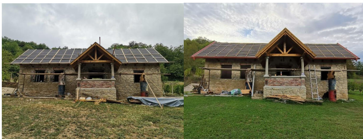
Slika 5.87: Krovna konstrukcija (lijevo), OSB ploče i lamperija na krovu (desno)
