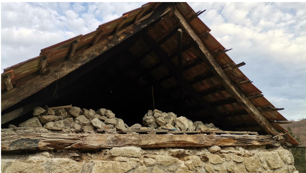
Slika 5.30: Rušenje zabatnog zida
