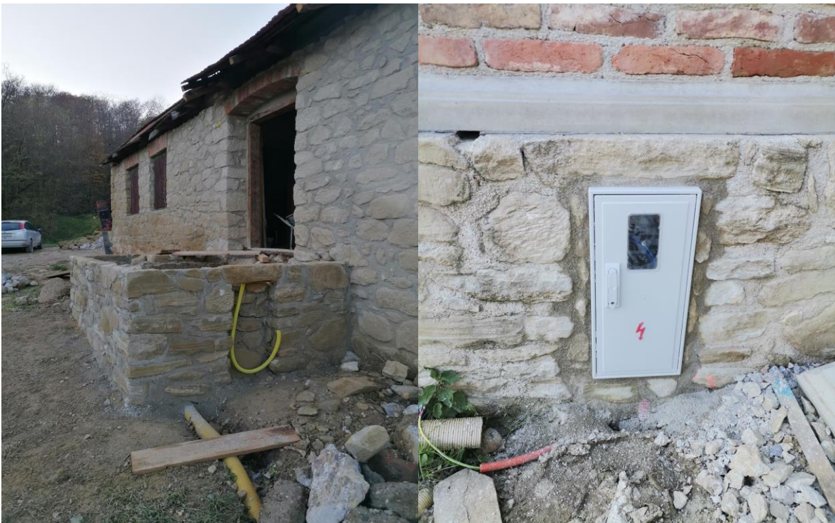
Slika 5.92: Ugradnja priključnog mjernog ormarića u nišu
