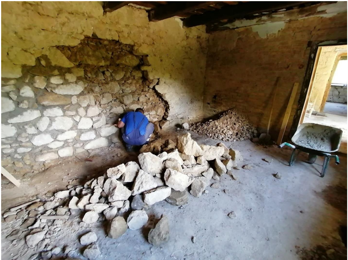
Slika 5.16: Rušenje zida i ponovno zidanje zida
