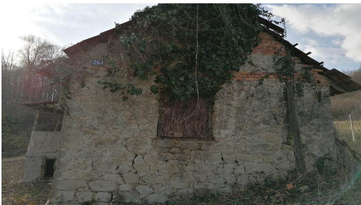
Slika 3.7: Zatečeno stanje – sjeveroistočno pročelje nakon čišćenja raslinja
