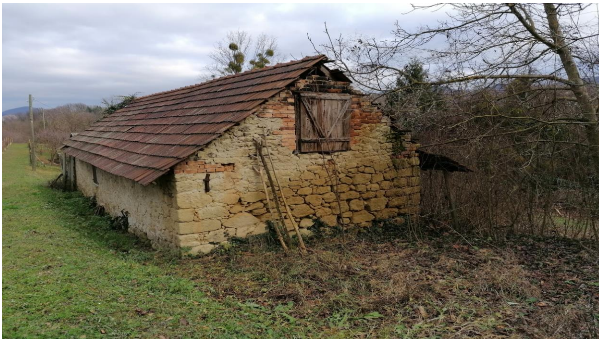
Slika 3.8: Zatečeno stanje – sjeverozapadno pročelje
