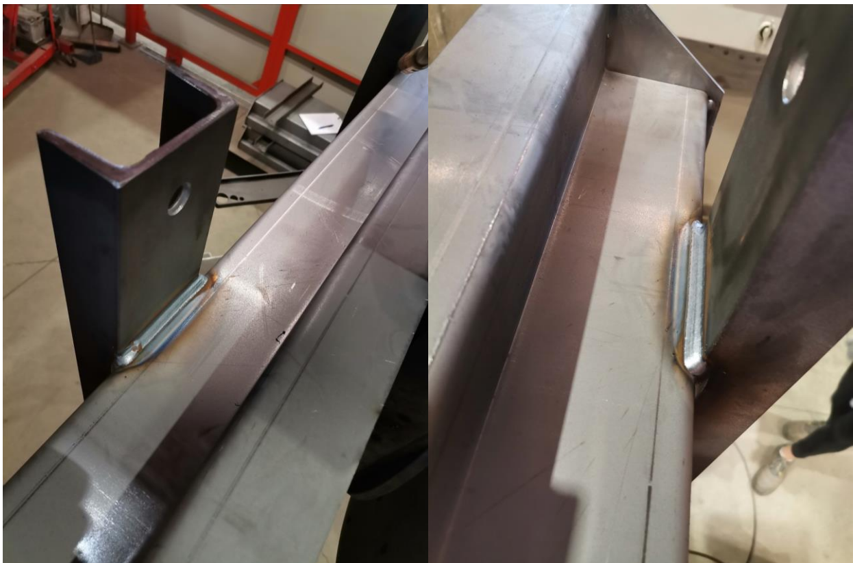
Slika 5.25. Dobiveni zavareni spoj s gornje strane prijevoznog sloga [osobne slike]
