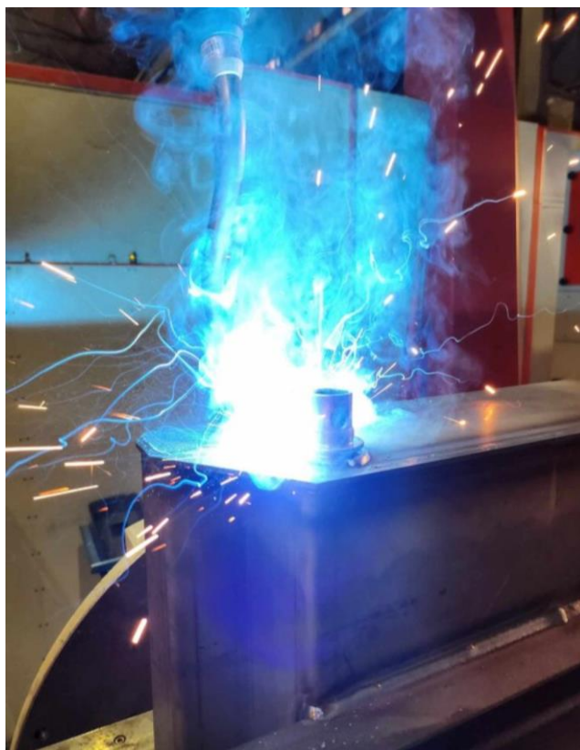
Slika 5.30. Postupak kružnog zavarivanja ispusta pomoću robota [osobne slike]
